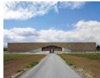
Abbildung 107: Weingut Arachon in Horitschon (Burgenland)
