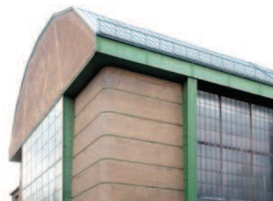
Abbildung 24: AEG - Turbinenfabrik, Detail
