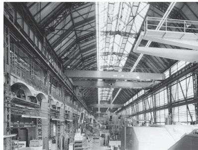
Abbildung 21: AEG - Turbinenfabrik, Innenansicht
