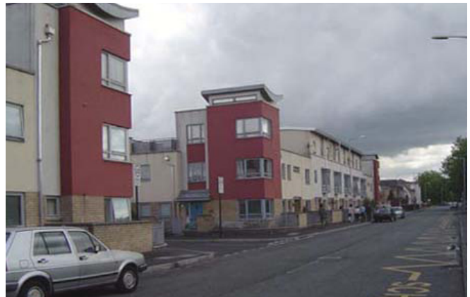
Abbildung 54: „Hulme“ vor dem Abriss
