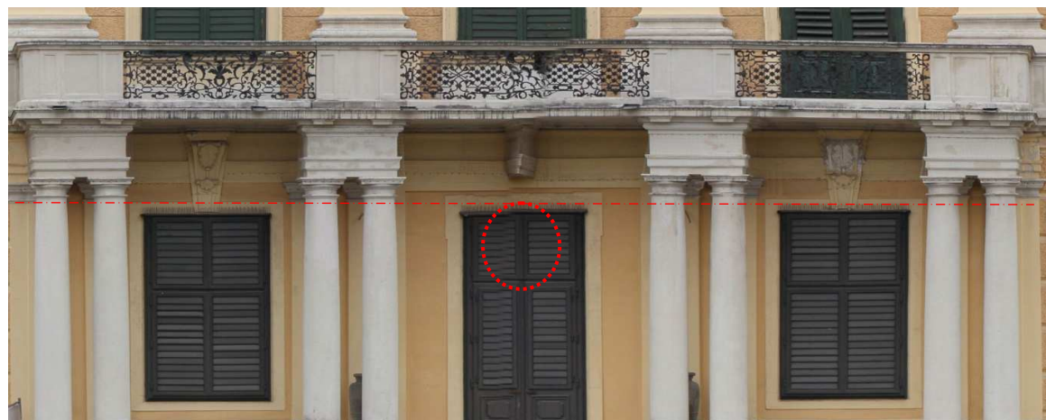
Abb.4-35: Verkantungen im Bereich des Einganges (markierter Kreis), und Abweichungen von horizontalen Linien bei Strukturen vor oder hinter der Entzerrungsebene (strichlierte Linie am Balkon)
