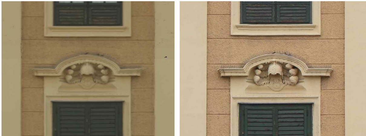
Abb.4-34: Vergleich von Orthophoto (links) und Entzerrung (rechts) – durch die höhere Qualität sind mehrere und genauer trennbare Strukturen erkennbar
