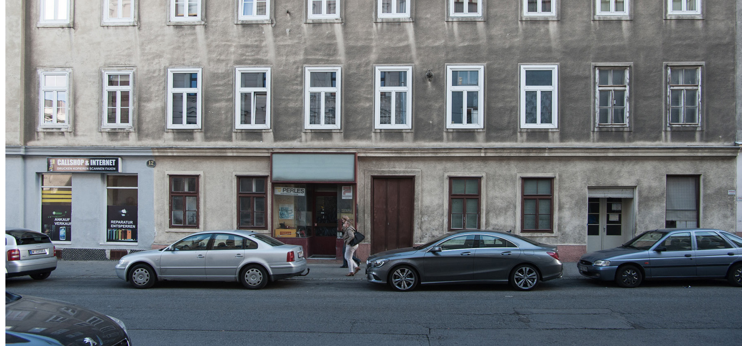
▲ Abb. 21: Ansicht Fassade Bestand
