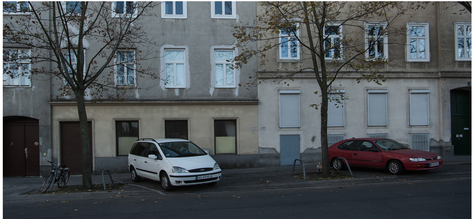
▲ Abb. 23: Ansicht Fassade Bestand
