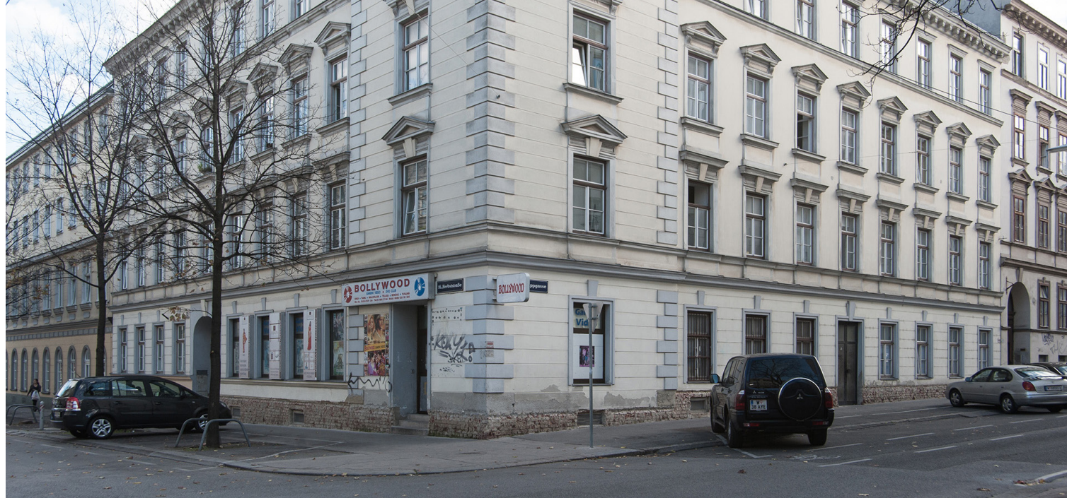
▲ Abb. 25: Ansicht Fassade Bestand
