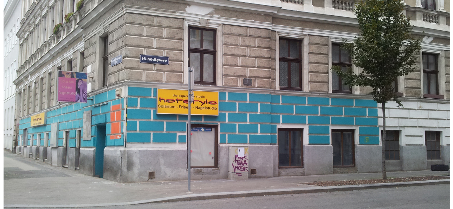
▲ Abb. 19: Ansicht Fassade Bestand
