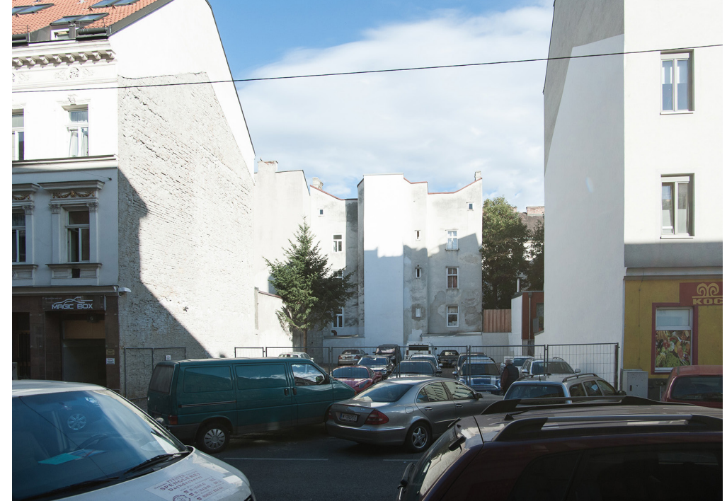
◀▲ Abb. 26, 27: Ansicht Bestand
