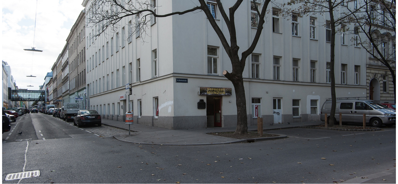
▲ Abb. 20: Ansicht Fassade Bestand
