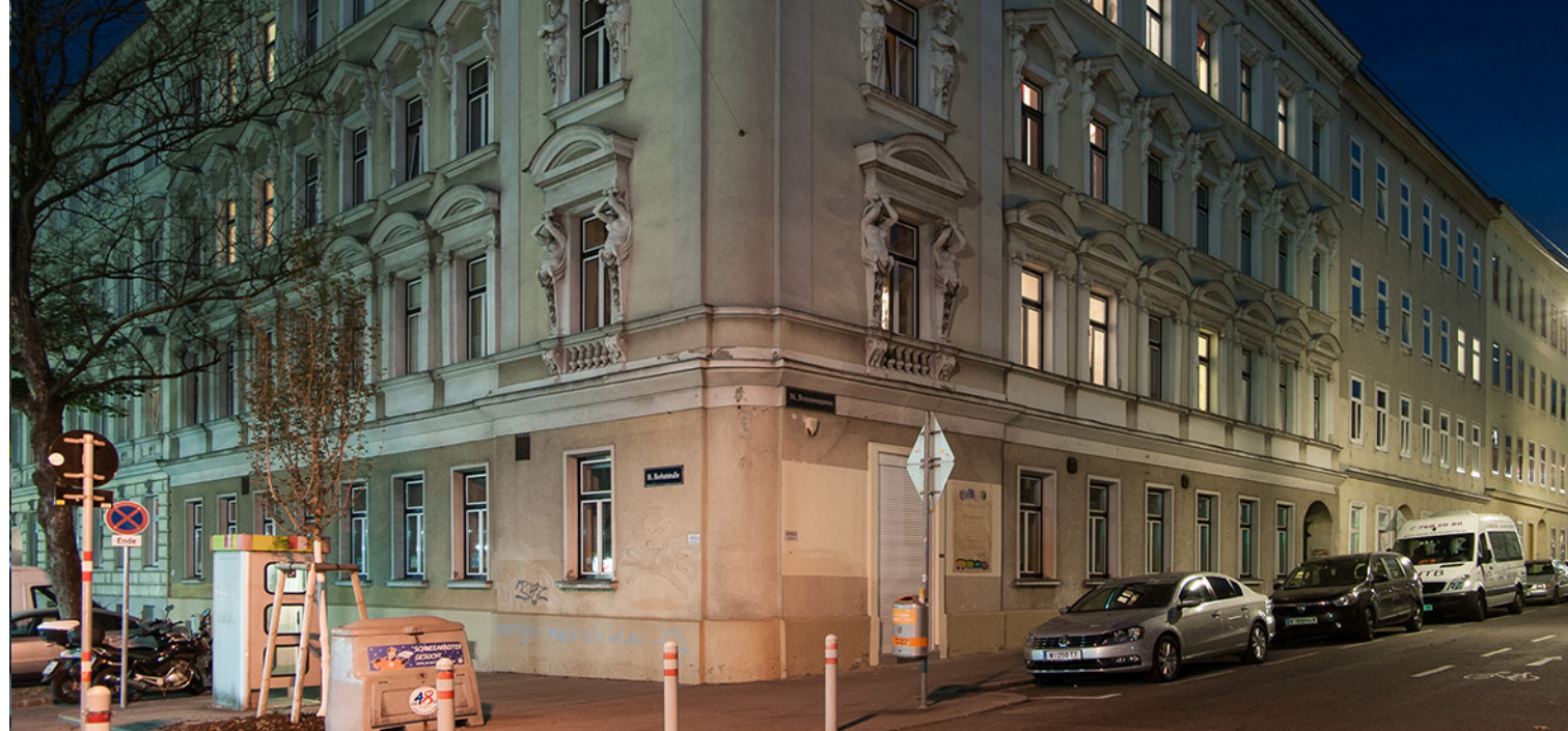
▲ Abb. 24: Ansicht Fassade Bestand
