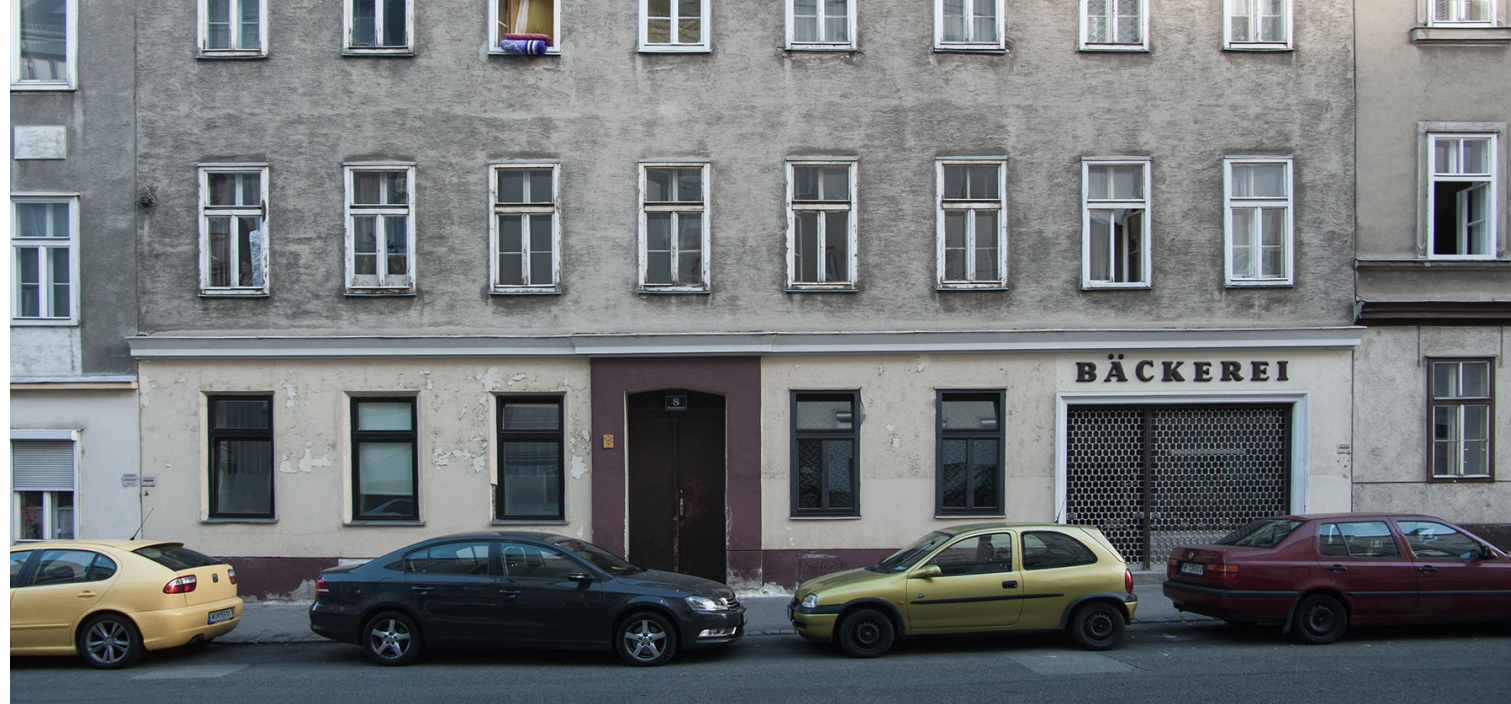
▲ Abb. 22: Ansicht Fassade Bestand
