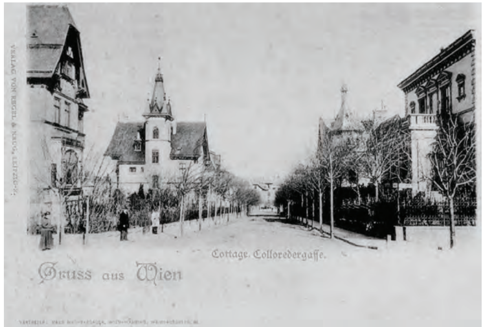
Abb. 54 Historische Aufnahme, Colloredogasse, Ecke G. Tschermakgasse, Richtung Gymnasiumstraße
