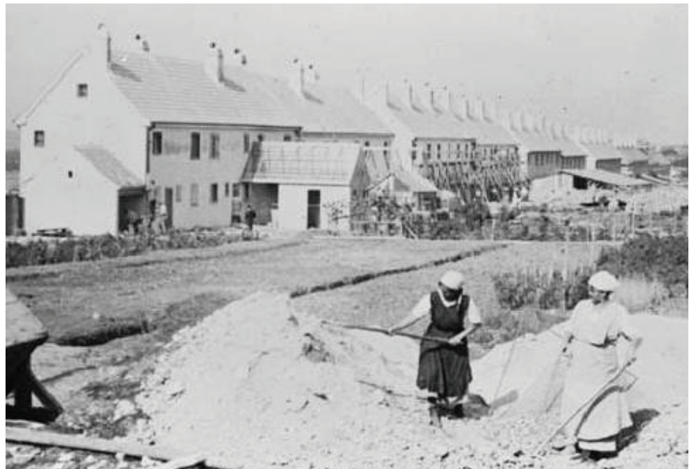
Abb. 69 Bauarbeiten bei der Gründersiedlung am Rosenhügel um 1920
