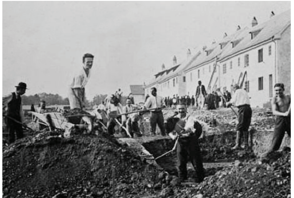
Abb. 68 Bauarbeiten bei der Gründersiedlung am Rosenhügel um 1920
