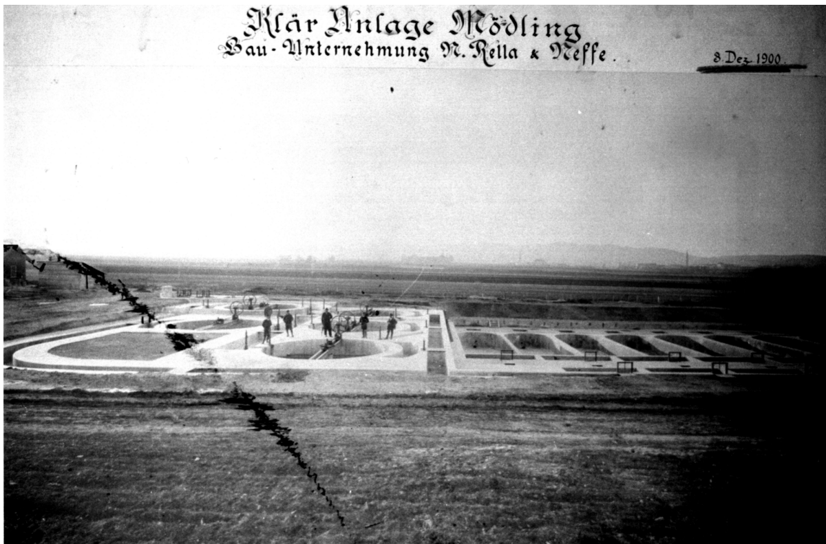
Abbildung 3-2: Bauphase der Kläranlage Mödling im Dezember 1900
