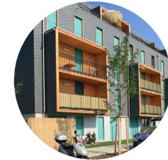
Holzoberflächen verschwanden hinter Faserzementplatten nach Abwägen der Bau und Wartungskosten ursprünglich geplant Holz-sicht Loggien nachträglich eingedeckt
