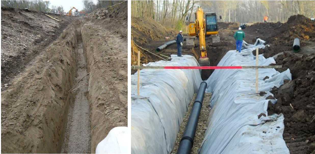
Abb. 4.2: Herstellung eines vliesummantelten Druckentlastungsgrabens am landseitigen Dammfuß mit eingebautem Drainagerohr zur Sickerwasserableitung.
