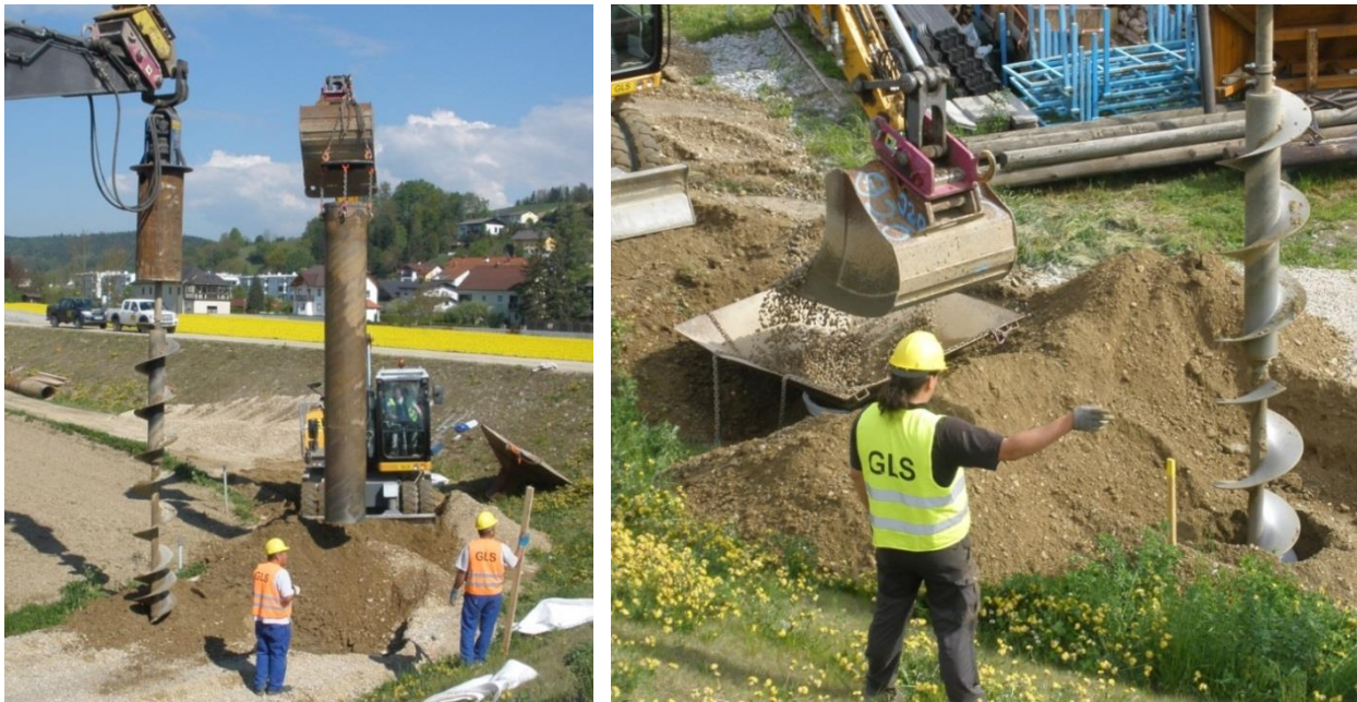
Abb. 4.4: Herstellung von vliesummantelten Kiessäulen mit der Methode der verrohrten Bohrung [13].
