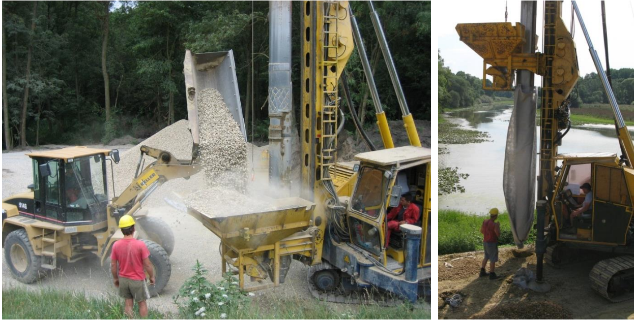
Abb. 4.3: Herstellung von vliesummantelten Kiessäulen mit dem Rüttelstopfverfahren [13].
