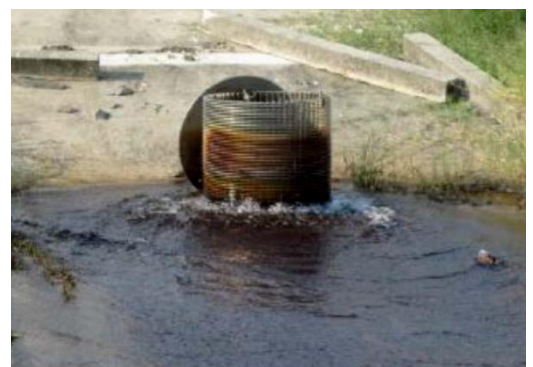
Abb. 4.9: Schematische Darstellung eines Entlastungsbrunnens gemäß EM 1110-2-1914 (adaptiert nach [99]). Detail der Sickerwasserableitung zum Graben und Detail des Brunnenkopfes ohne Schutzkappe [2].
