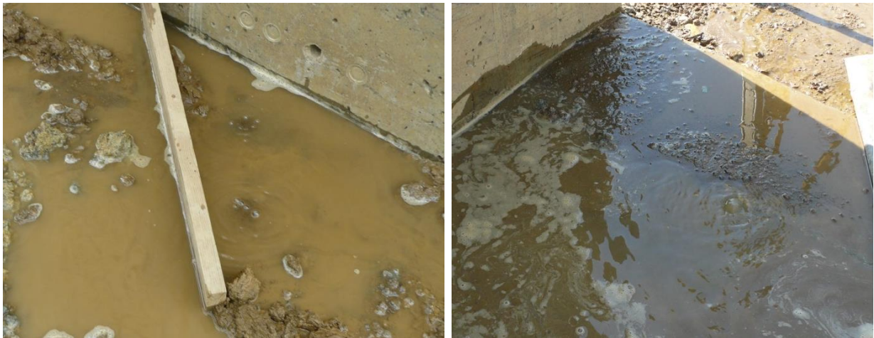
Abb. 6.18: Lokales Erosionsversagen der landseitigen Deckschicht während der Modellversuche.
