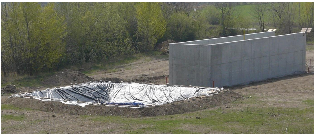
Abb. 6.1: Versuchsanlage nach Fertigstellung der Bauarbeiten durch Unterstützung der Firmen Pittel + Brausewetter Gesellschaft m.b.H. und Hinteregger und Söhne GmbH .
