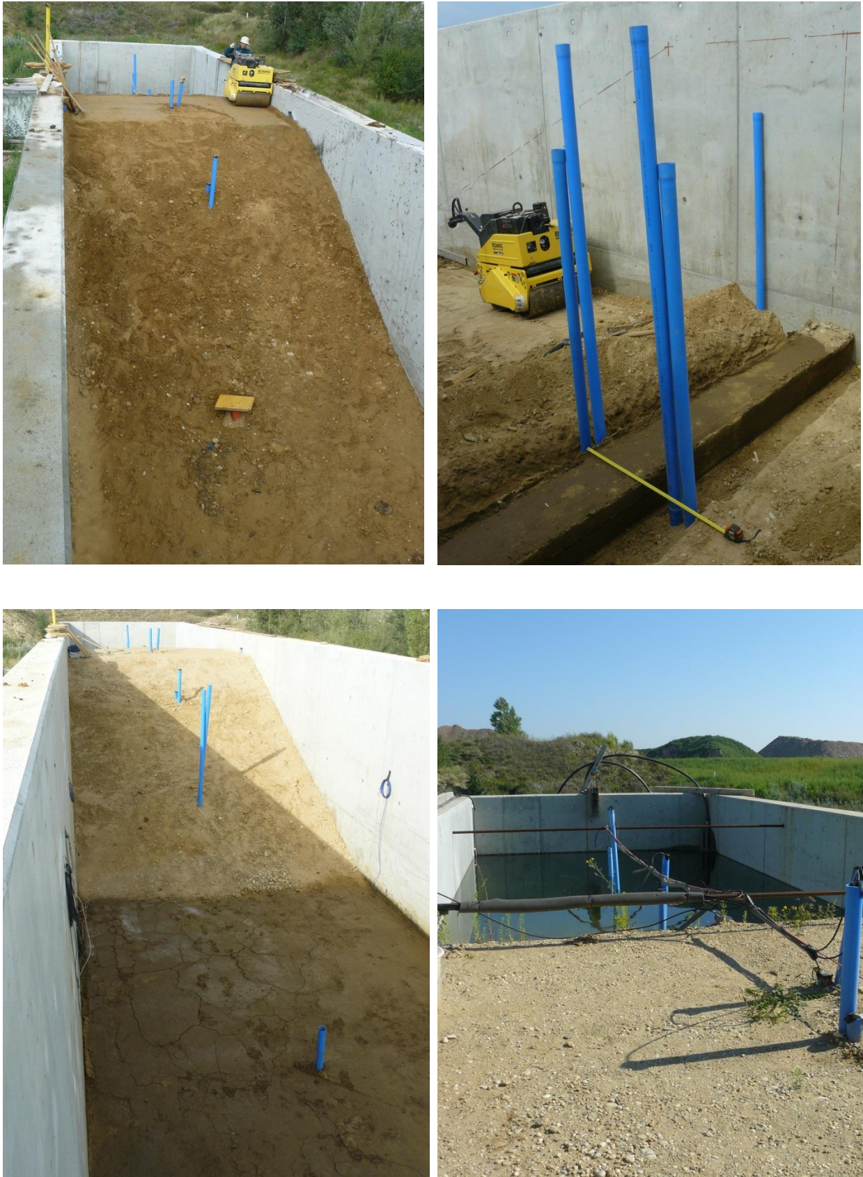
Abb. 6.7: 1:1 Dammodell: Schütтарbeiten des Dammkörpers (oben links); Einbau des Dichtkernes im Damm (oben rechts); Dammodell nach Fertigstellung (unten links); Einstau während eines Modellversuches (unten rechts).
