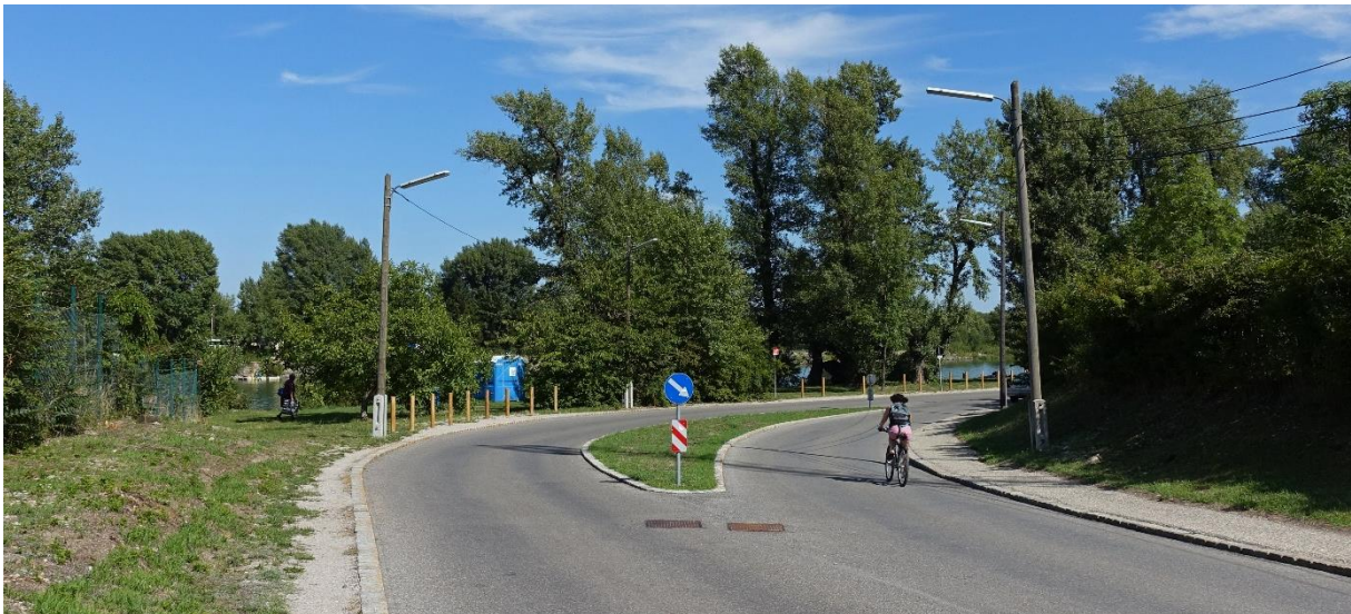
Abb. 44: Fahrbahnsteiler in der Fahrradstraße Kuchelauer Hafestraße 407
