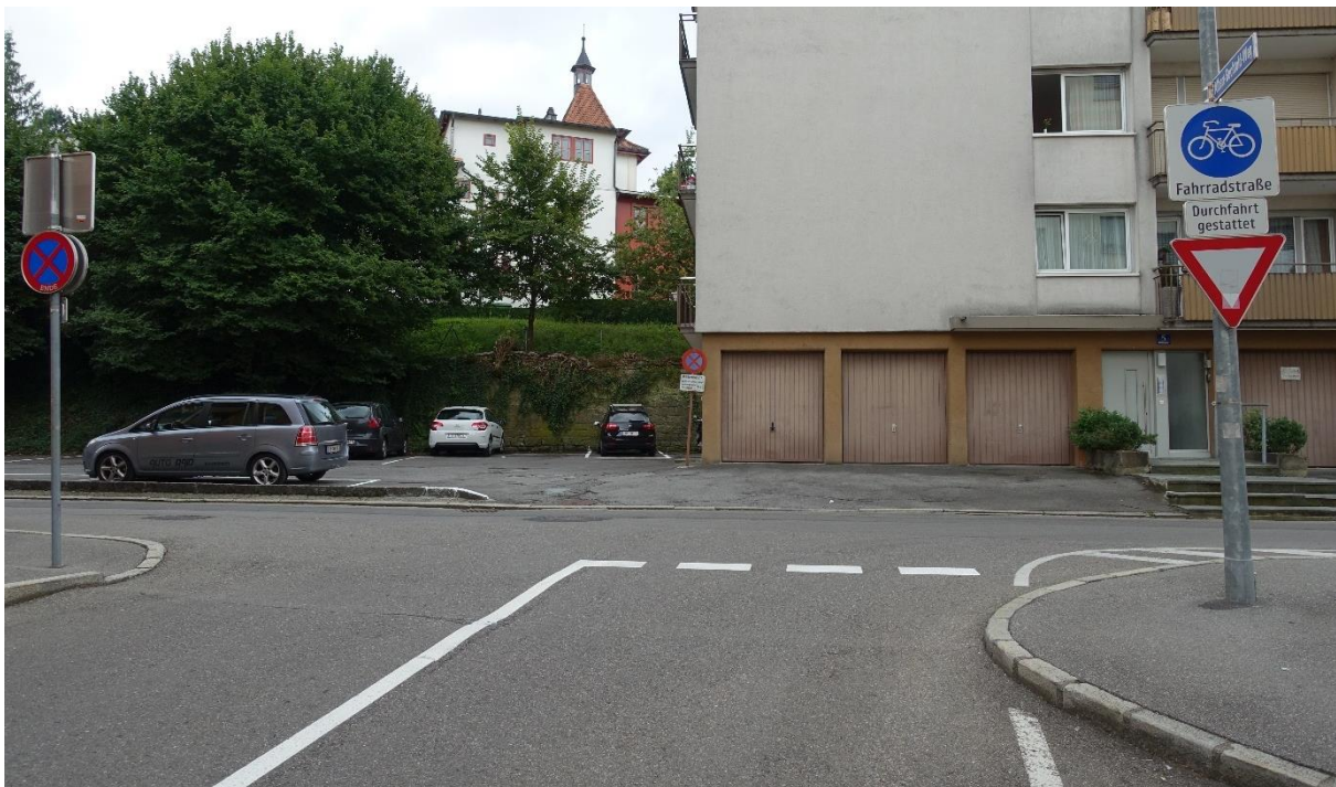
Abb. 63: Beschilderung in einer einmündenden Straße der Fahrradstraße Klostergasse 452
