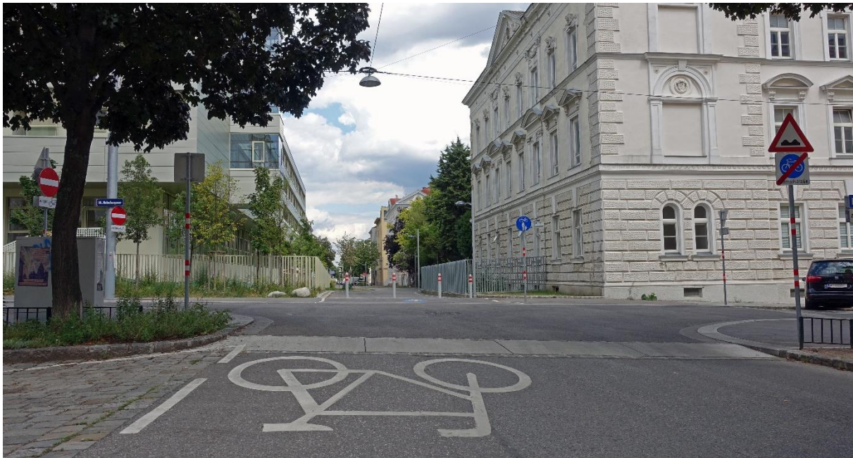
Abb. 53: Fahrbahnanhebung am östlichen Beginn der Fahrradstraße Goldschlagstraße 429
