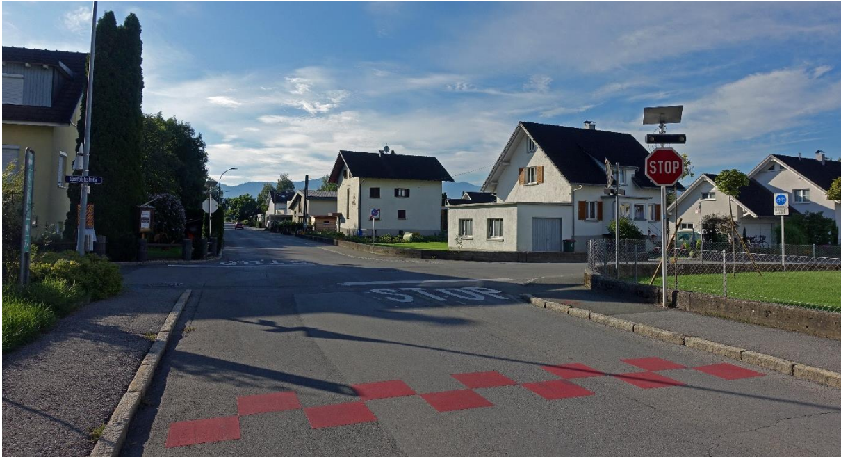
Abb. 71: Gestaltung einer Kreuzung der Fahrradstraße Wallstraße – Sportplatzstraße 474
