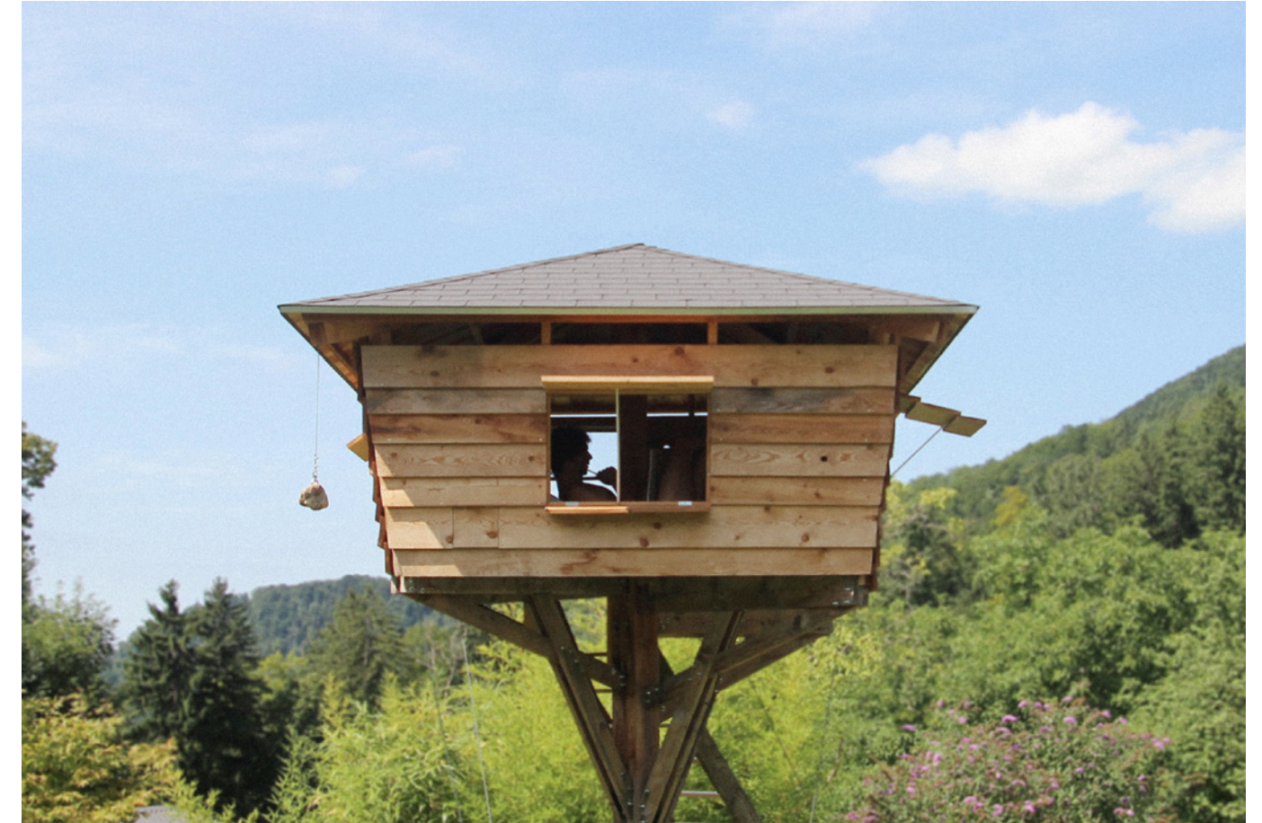
rechts: Ansicht der Süd-Ost- Fassade mit geöffneten Klappen
