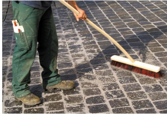
**Abb. 2 - Herstellung von ungebundener Pflasterung**
