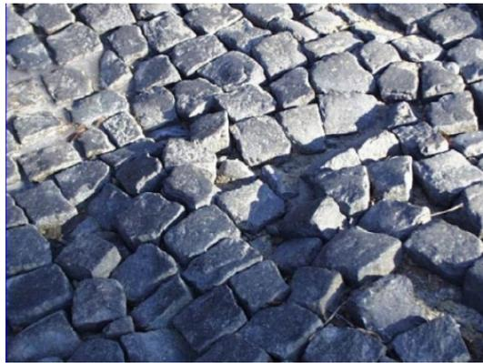
**Abb. 9 - Ausgekippte Pflastersteine infolge Fugentleerung**
