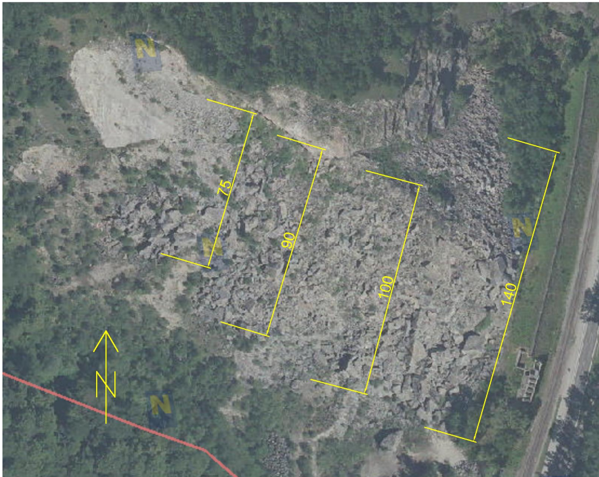
Abbildung 16: Abmessungen der Halde 2002 (Fotounterlage: NÖ Atlas 2014)
