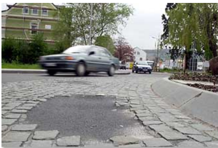
Abb.91 Aufpflasterungsbeschädigung [82] Abb.92 Randbeschädigung, Assenovgrad, Bulgarien [89]
