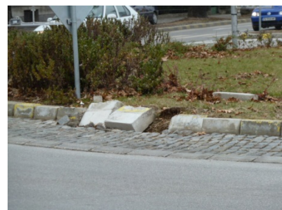
Abb.91 Aufpflasterungsbeschädigung [82] Abb.92 Randbeschädigung, Assenovgrad, Bulgarien [89]
