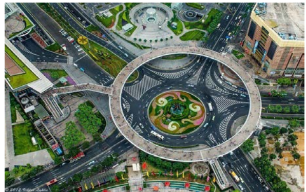
Abb.26 Kreisverkehr in Shanghai, China [64]
