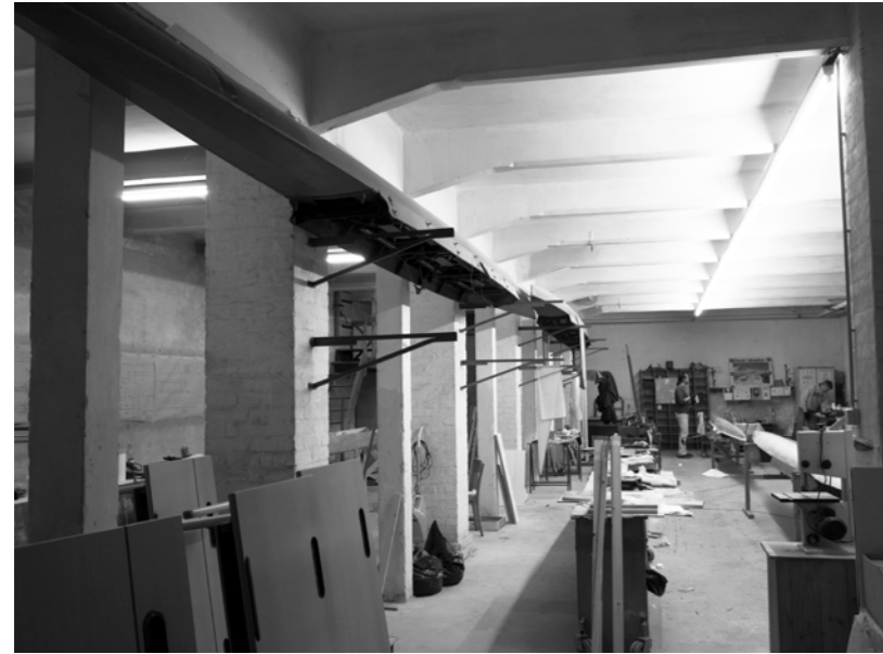
KELLERGESCHOSS DES TUNRSAALES Nutzung durch den Ruderverein
