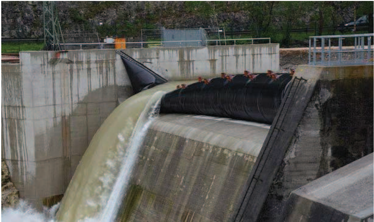
Abb. 6.8 Absenkung des luftgefüllten Schlauchwehres in Kibling [www.pnp.de]
