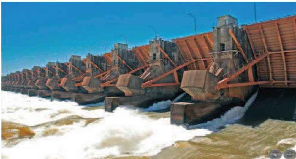
Abb. 4.1 Die Drucksegmente des Staudammes Yacyreta am Fluss Parana [25]
