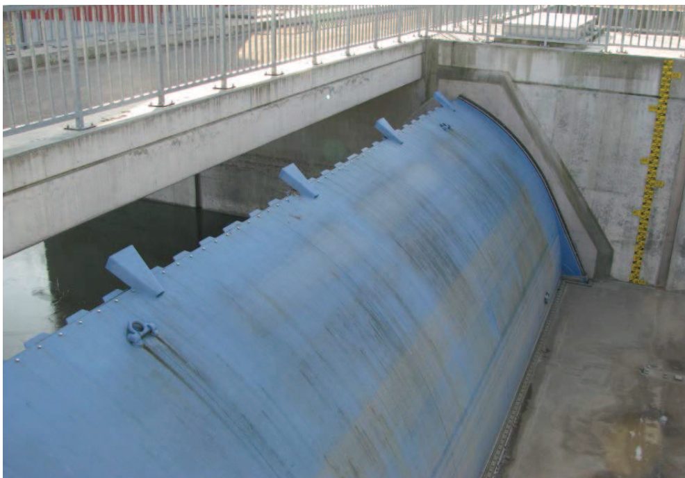
Abb. 5.2 Fischbauchklappe- Wasserseite [Wikimedia]
