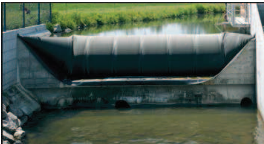
Abb. 6.3 An Schräge Seitenwände angeschlossene Schlauchwehr [www.wol-tec.de]
