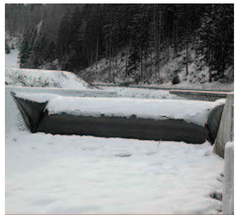
Abb. 6.8 Absenkung des luftgefüllten Schlauchwehres in Kibling [www.pnp.de]
