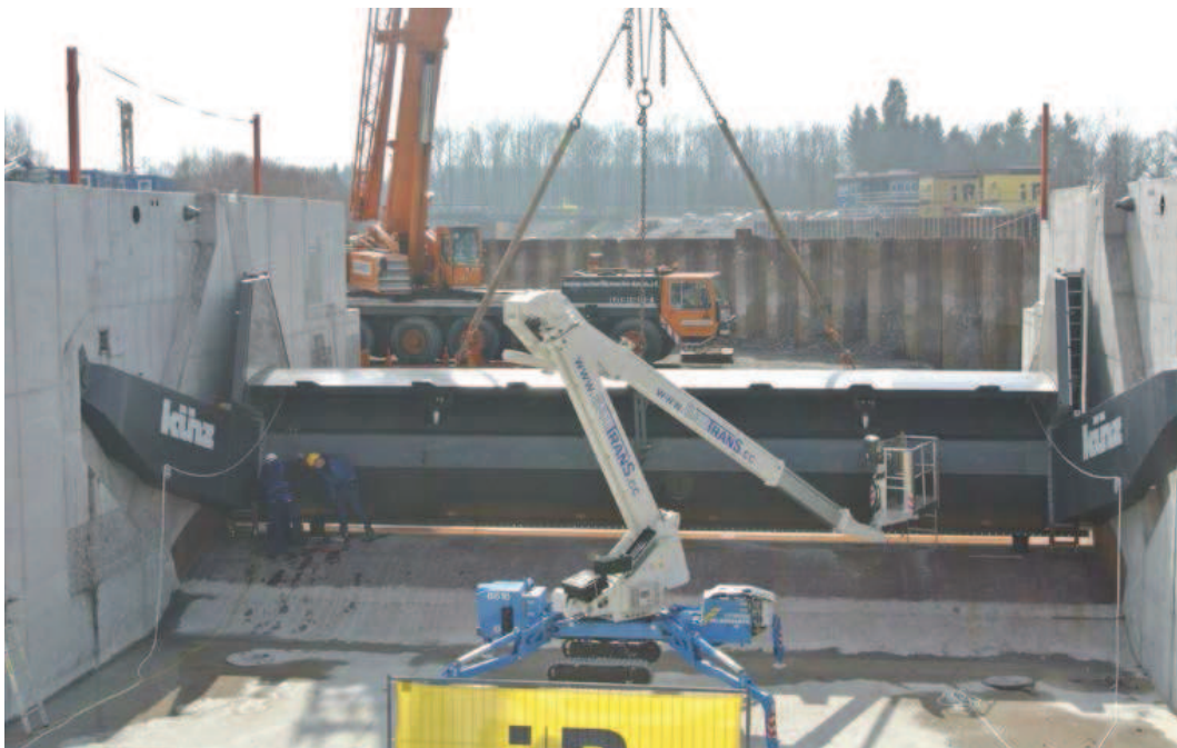
Abb. 4.21 Kraftwerk Illpitz: Höhe Segment: 3,10m; Höhe Aufsetzklappe: 1.50m; Breite Segment: 15m; [http://www.feldkirch.at/]
