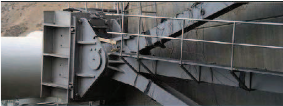
Abb. 4.5 Drehlager eines Segmentes ( bridgestes.com ) ebenfalls schematische Darstellung im Drauf- und Ansicht
