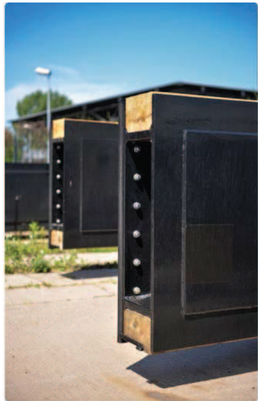
Abb. 3.15 Wehranlage mit eingesetzten Notverschlüssen (Dammbalken) [3]
