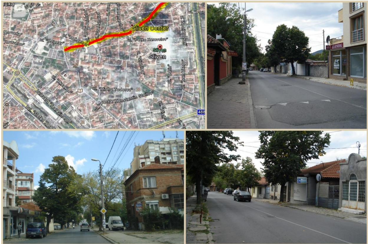
Abbildung 83: Straße "G.S.Rakovski" (Ist-Zustand)
