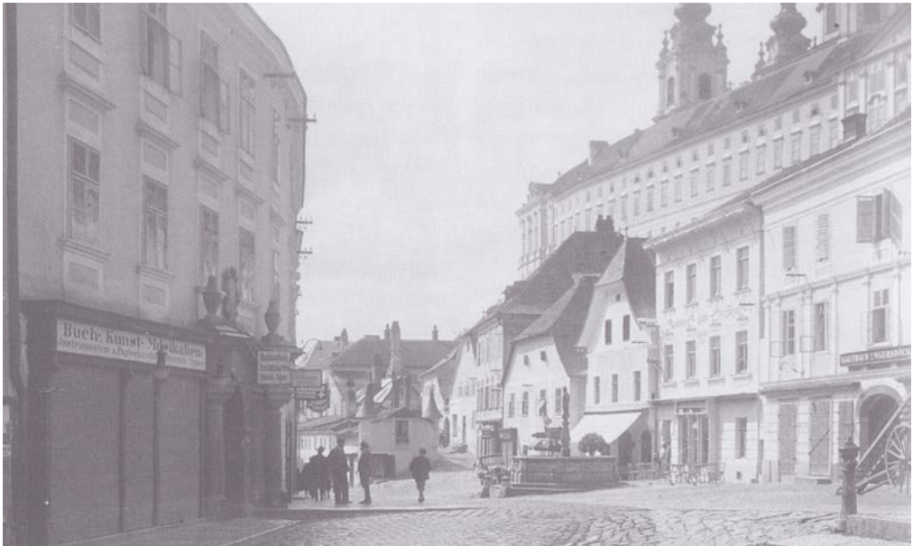
Abb. 44: o.A. (Fotograf_In), Blick von der Wiener Straße Richtung Stift, Fotografie, Melk o.J.
