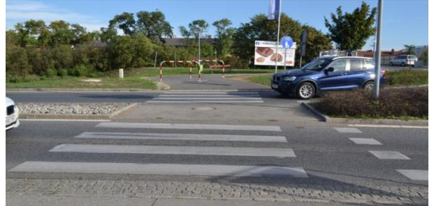
**Abbildung 143: Kreisverkehrsanlage II-3 – Schutzweg und Radfahrerüberfahrt (östlicher Arm)**
