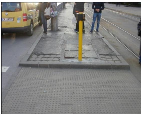
Abbildung 62 Nicht angepasste Bordsteine an einer Inselhaltestelle, eigene Aufnahme
