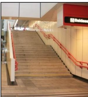
Auf Abb. 44 ist ein positives Beispiel für eine Treppe dargestellt. Die hat eine ausreichende Breite, die Handläufe sind doppelseitig, fangen vor dem Treppenlaufbeginn an, weisen guten Kontrast zur Wand und sind durchläufig über den Zwischenpodest montiert. Zur Treppe führt ein Leitstreifen und die erste Stufe ist kontrastierend markiert.
