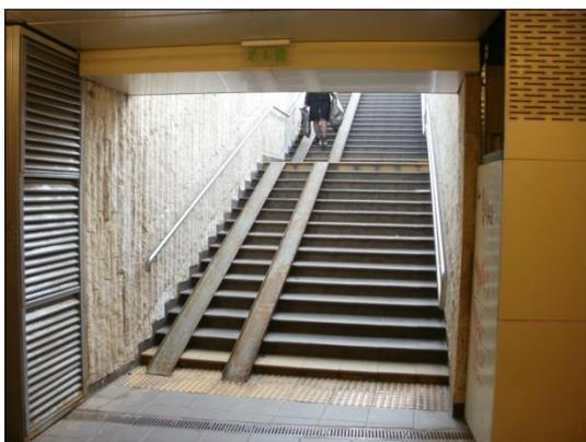
Abbildung 95 Schienen als Anlage zur Überwindung von Höhenunterschieden, eigene Aufnahme
