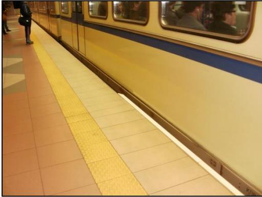
Abbildung 100 Warnstreifen aus Noppenplatten, eigene Aufnahme
