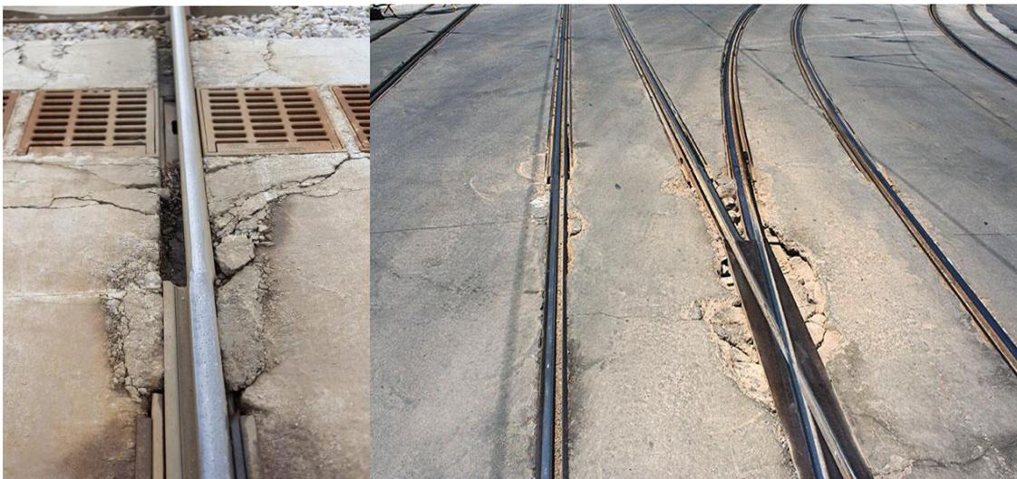
Abbildung 139 und Abbildung 140 Zustand der vor 2 Jahren renovierten Trasse der Linie 7 [71]
