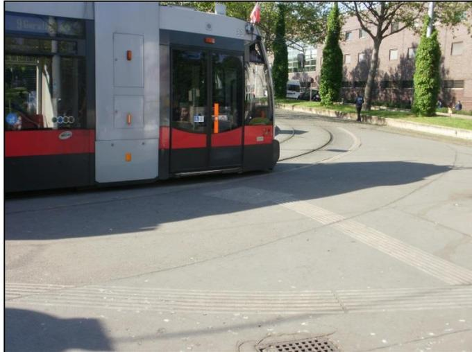
Abbildung 76 Taktiles Leitsystem an einer Straßenbahnhaltestelle, eigene Aufnahme
