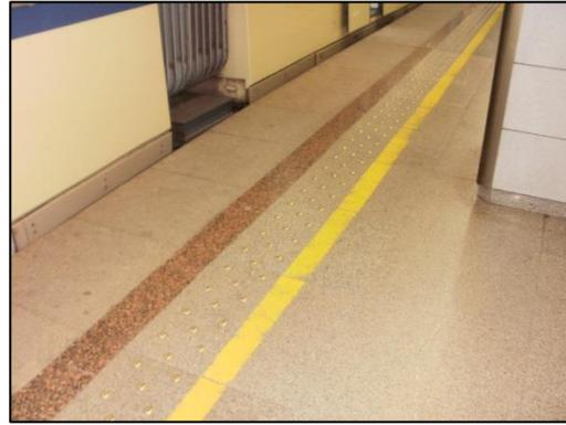
Abbildung 101 Warnstreifen aus Metallnoppen, eigene Aufnahme
