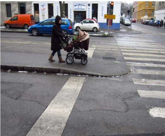
Abbildung 74 Inselhaltestelle mit einer Absenkung, eigene Aufnahme
