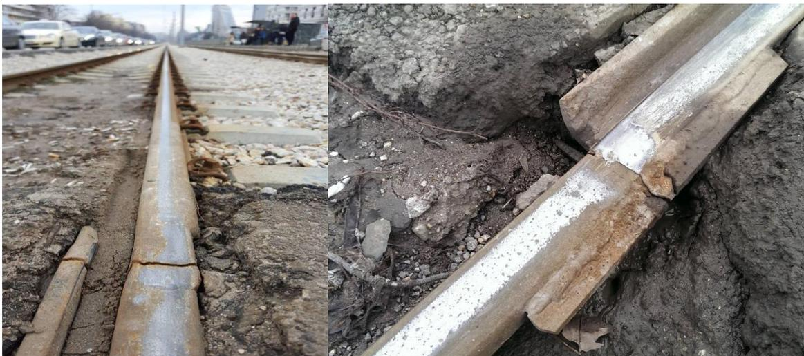
Abbildung 141 und Abbildung 142 Zustand der vor 2 Jahren renovierten Trasse der Linie 7 [71]
