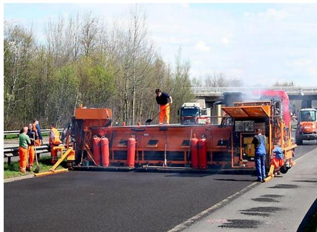
Abbildung 3: Einbau des Gussasphaltes[4]
