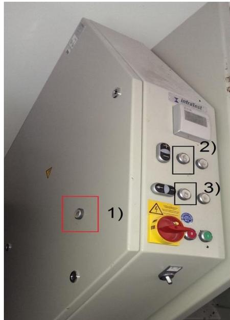
Abbildung 29: Kombination 1) + 2) - Deckel Aufmachen ; 1)+ 3) - Deckel Zumachen
