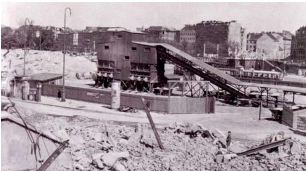
**Abbildung 5: Die schwedische Maschinen-Konstruktion, mit der auf dem Franz-Josef-Kai Bausteine aus dem Schutt gepresst wurden.**
