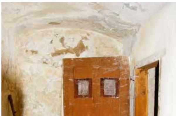
Abb. 169: Ausblühungen an der südlichen Wand zum Erdreich im Erdgeschoß, 2015-06-04
