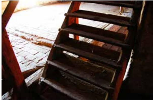
Abb. 313: Dachgeschoß (Raum 18), Detail eingeschobene Stiegenauftritte in Wangenholzer, 2015-06-05
