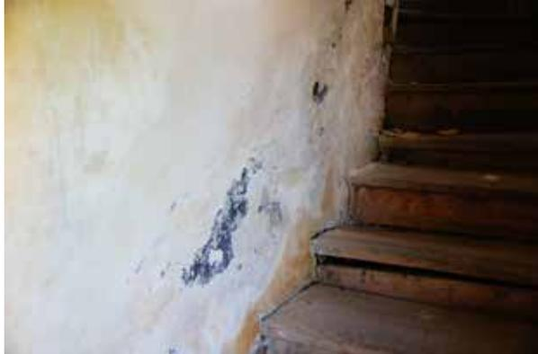
Abb. 228: Stiegenaufgang (Raum 7), Schäden im unteren Bereich der Stiege links, 2015-06-05
