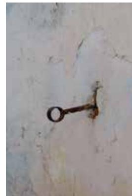
Abb. 232: Stiegenaufgang (Raum 7), Geländerbefestigung, 2015-06-05
