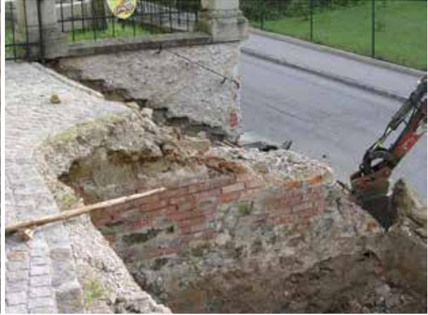
Abb. 122: Teile der alten südlichen Außenwand der Lagerräume aus Stein- und Ziegelmauerwerk, 2005-09-26
