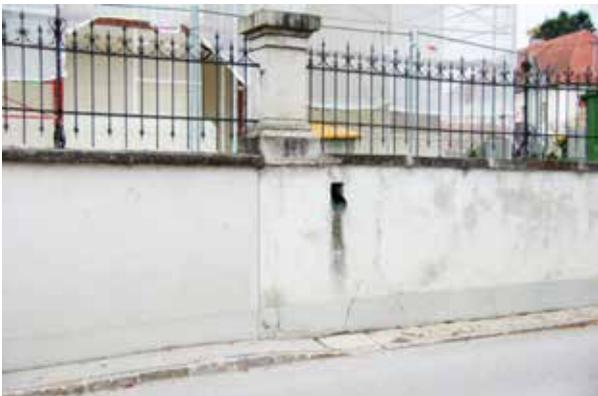
Abb. 116: Bauwerksfuge und unterschiedlich verwitterte Flächen der Friedhofsmauer, 2015-10-29
