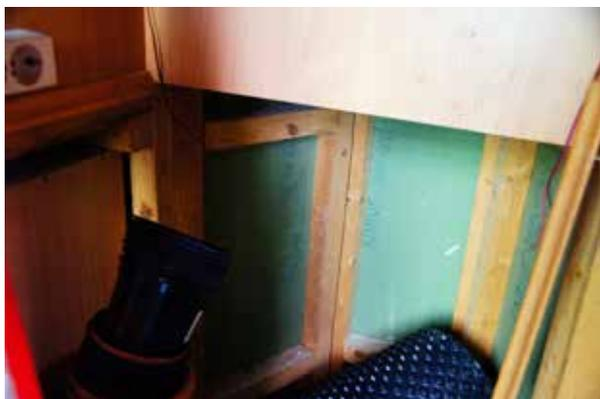
Abb. 289: Jugendtreff (Raum 16), Holz-Gipskarton-Konstruktion der Bar, 2015-06-05
