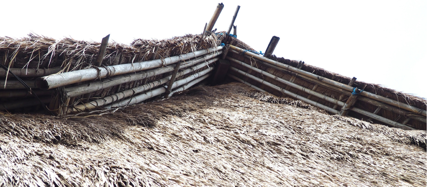
Abb.16: Strohdach mit Unterkonstruktion aus Bambus
