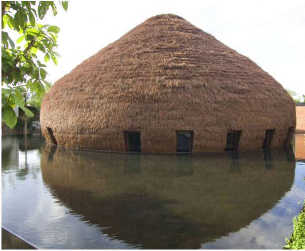
Abb.19: Strohdachdeckung
