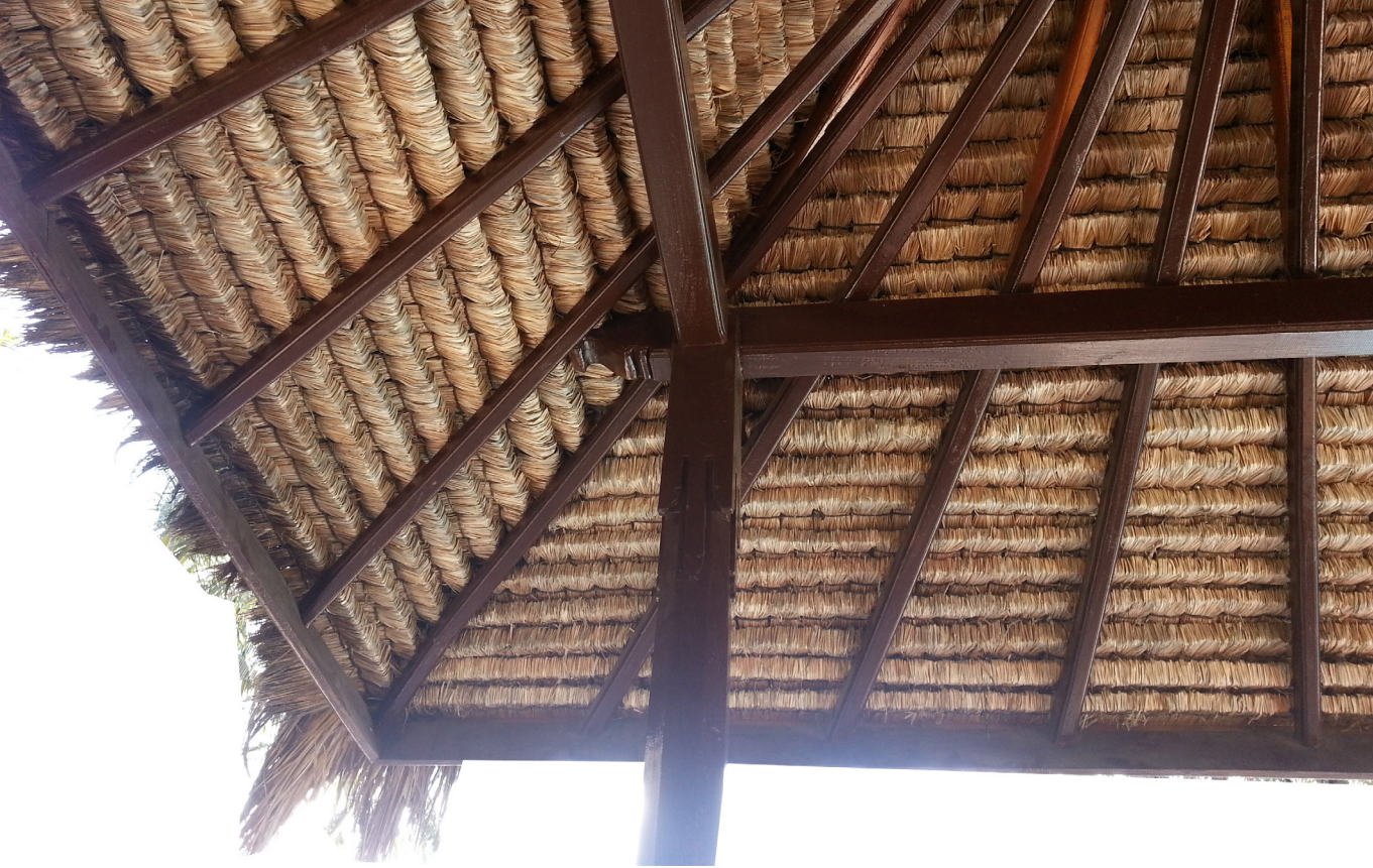
Abb.15: Strohdach mit Unterkonstruktion aus Holz
