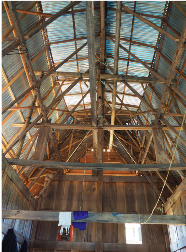
Abb. 20: Offenliegende Dachkonstruktion mit Wellblechdeckung (tongkonan)
