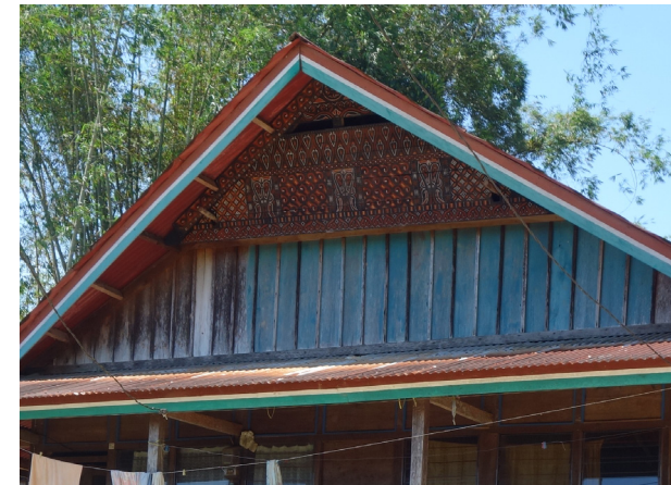
Abb. 21: Ausschnitt Fassadenornamentik der Stirnseite mit Öffnung für Luftaustausch
