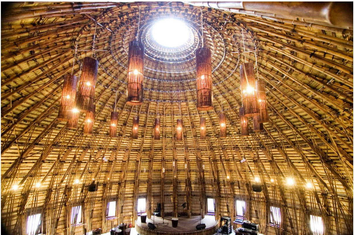
Abb.18: offen sichtbare Bambusstruktur
