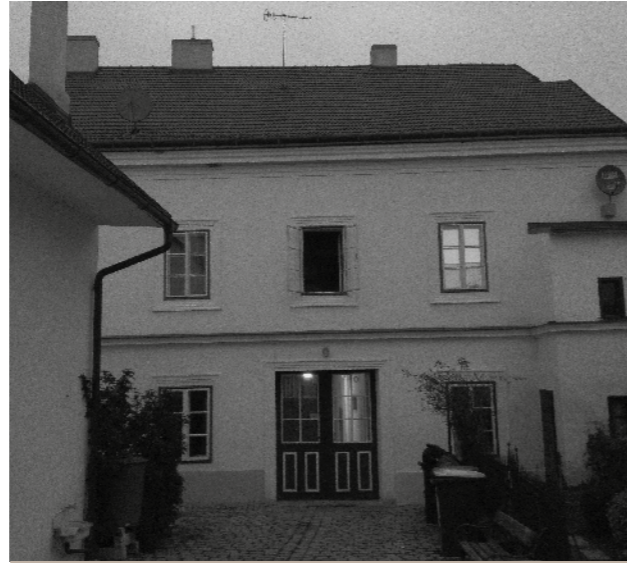
Abb. 28.08 --- Fassade Süd Gebäude Gl.
