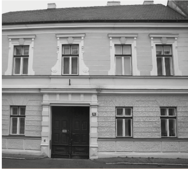
Abb. 28.07 --- Fassade Nord Gebäude Gl.
