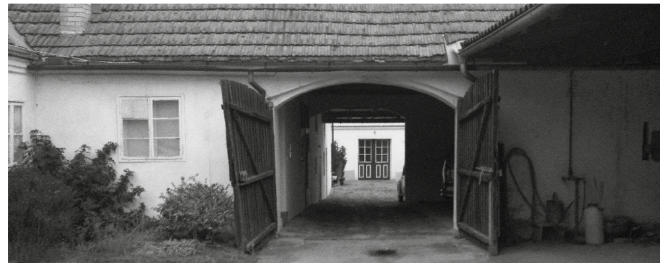
Abb. 28.28 --- Fassade Süd Gebäude GIII.
