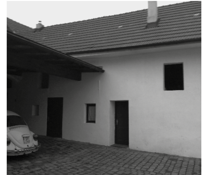
Abb. 28.19 --- Fassade Ost Gebäude GII.
