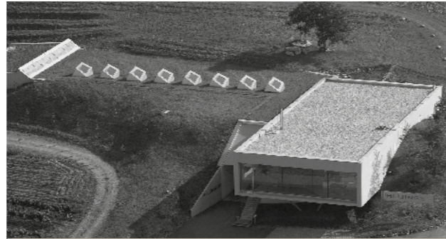
Abb. 051 --- Weingut Hillinger, 2004; Verdeutlichung der Erdverbundenheit und Regionalverankerung durch Eingrabung des Baukörpers
