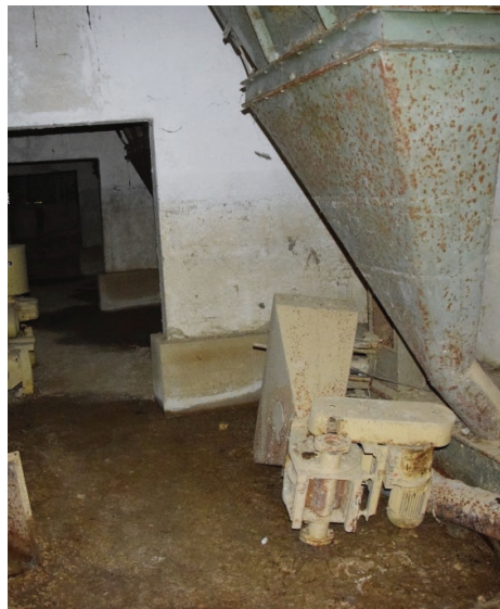
Abbildung 70 o.: oberstes Geschoß im Siloturm, die Öffnungen zu den Silos sind mit Metalldeckel verschlossen
