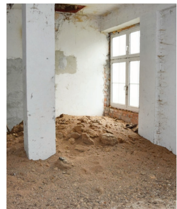
Abbildung 66: Einbau eines Fensters in eine nichttragende Mauer im Mischfutterwerk
