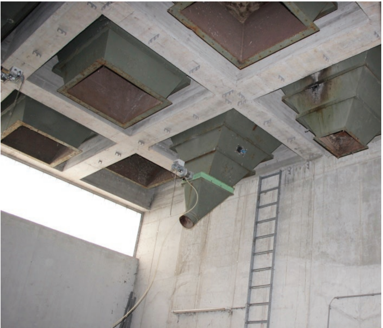
Abbildung 69: Zubau von 1989, der Stahlbetonrost trägt die Silos, teilweise abgetragene oder heruntergefallene Trichter
