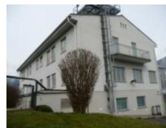
Bürotrakt aus Südwestseite
