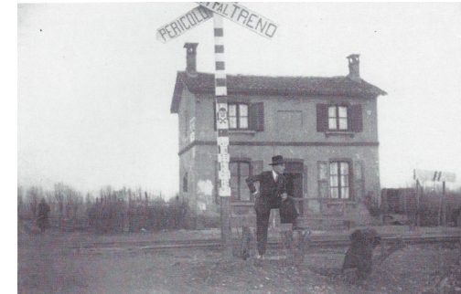
08 Bahnhof San Giuliano 1931
