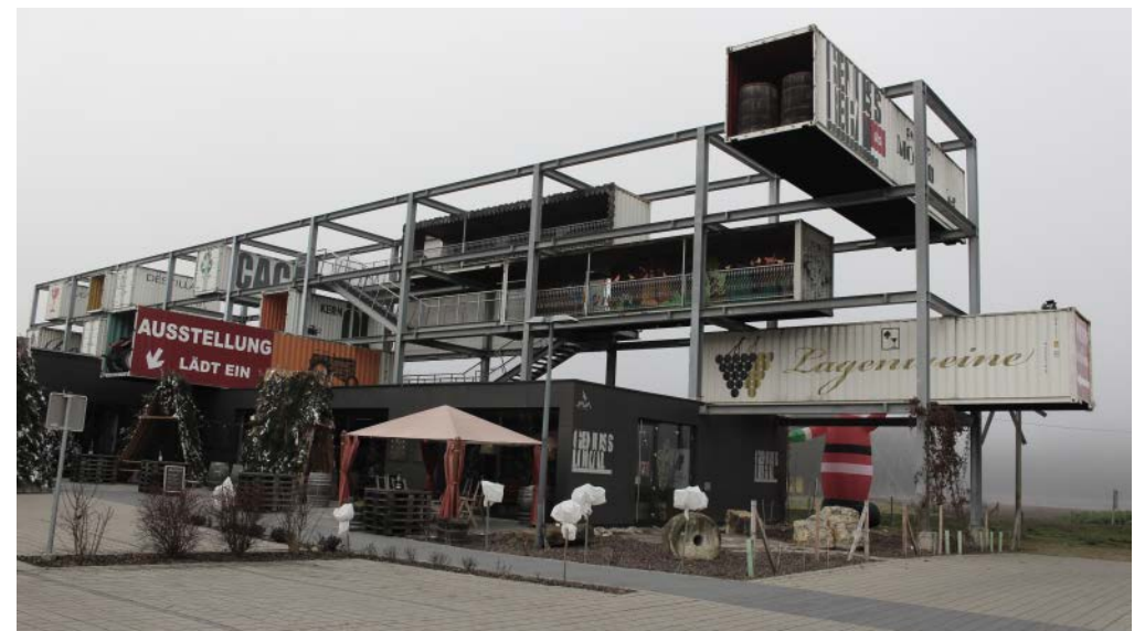
Außenansicht Parkplatz Abb. 23
