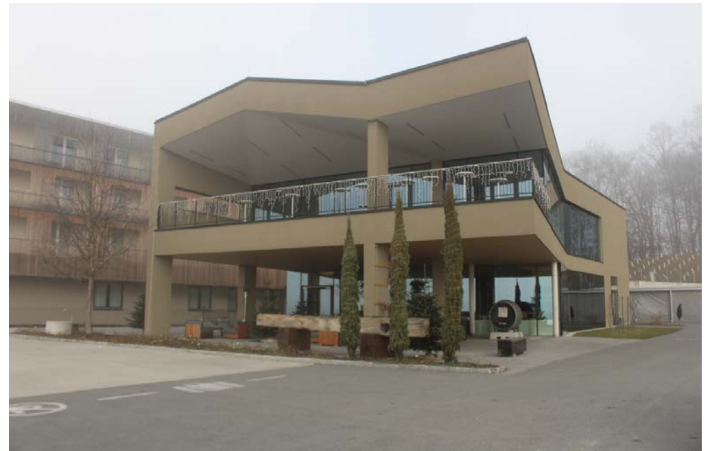
Außenansicht Seminarräume Abb. 30
