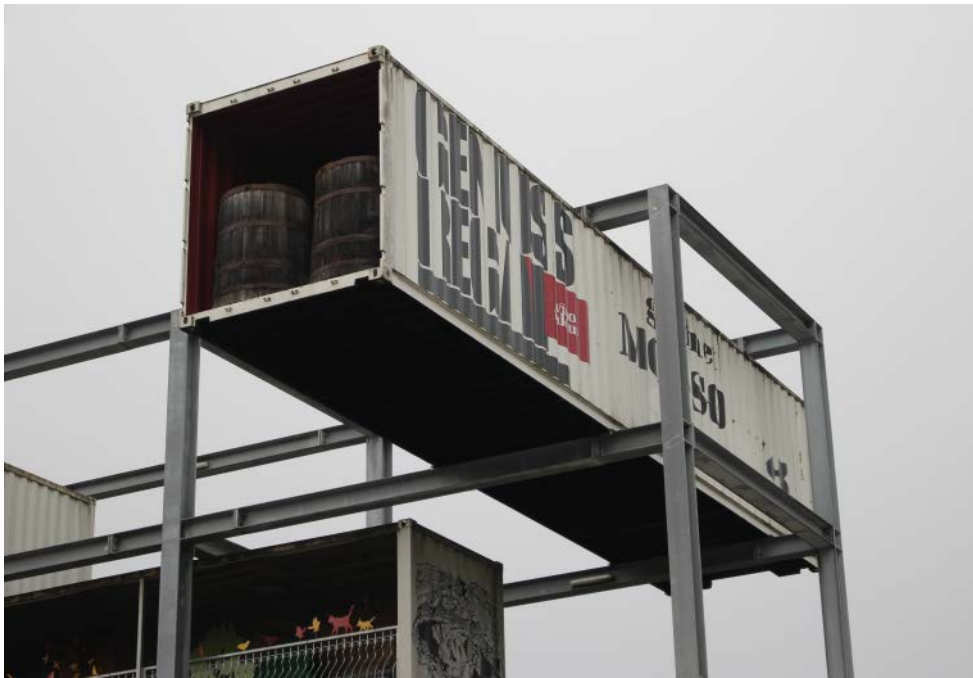
Container in Stahlregal „gehängt“ Abb. 21
