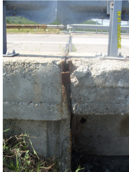
Abb. 80: Übergangskonstruktion: Korrosion
