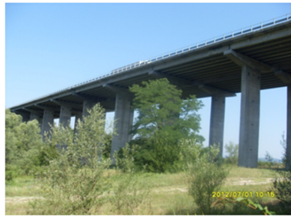
Abb. 76: Viadukt bei Tserovo: Ansicht 134
