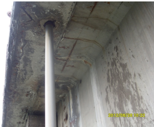
Abb. 57: Randbalken: Abplatzungen
