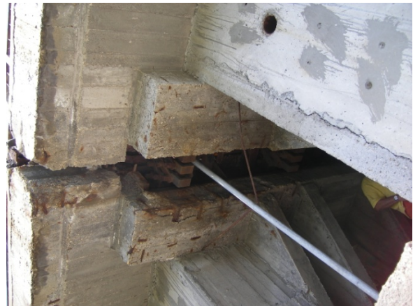
Abb. 74: Übergangskonstruktion: Korrosion
