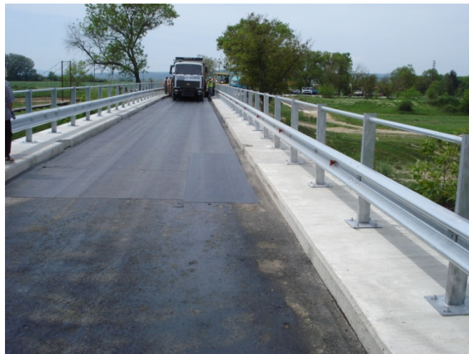
Abb. 32: Verlegung einer verklebten Dichtungsschicht 56
