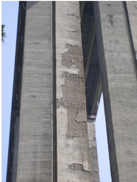
Abb. 63: Stützen: Abplatzungen
