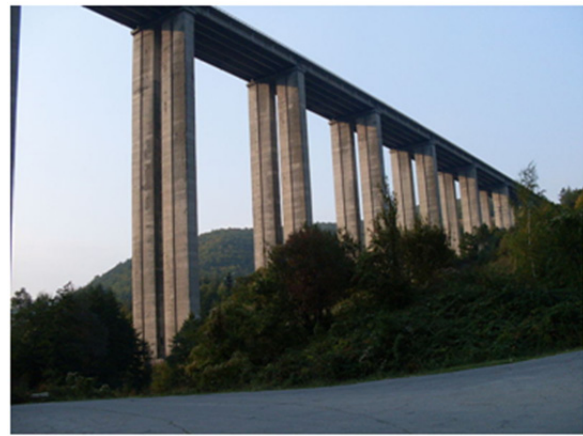
Abb. 56: Viadukt Bebresch: Ansicht 123
