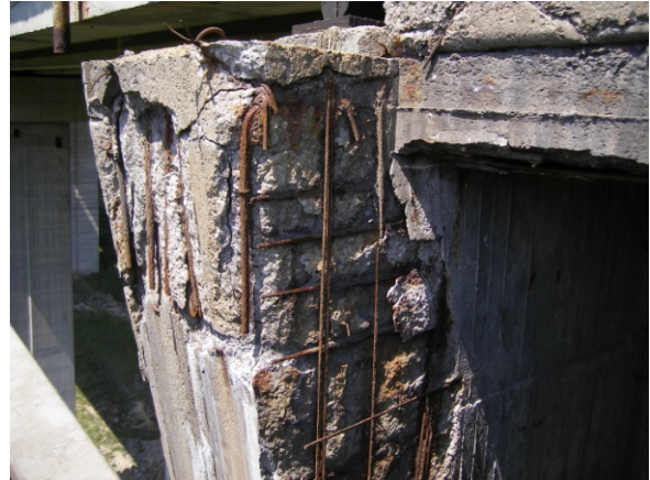
Abb. 70: Riegel: Abplatzungen
