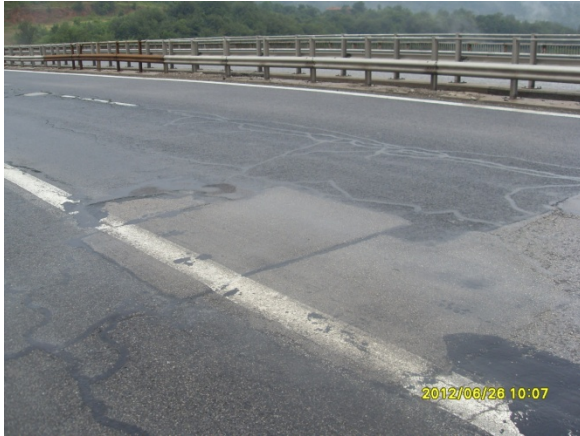
Abb. 61: Fahrbahnbelag: Schadstellen
