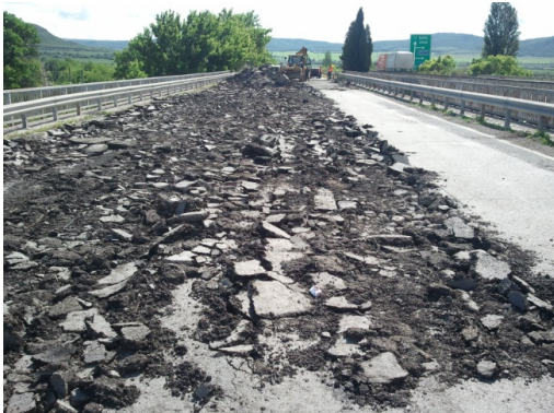
Abb. 43: Zerstörung des alten Fahrbahnbelags
