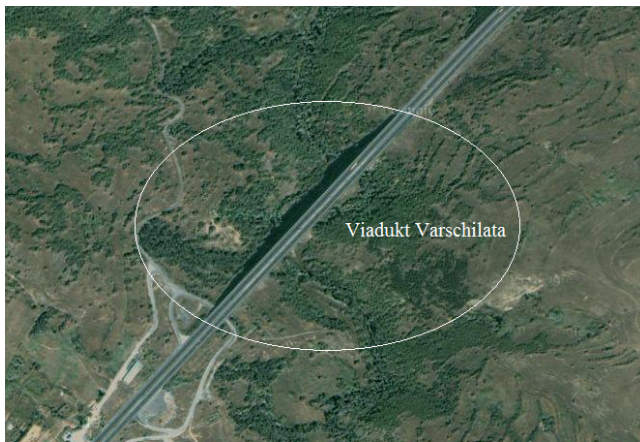
Abb. 67: Viadukt Varschilata: Luftaufnahme 128
