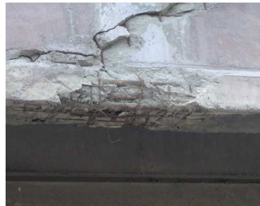
Abb. 90: Anprallschaden: Träger 1
