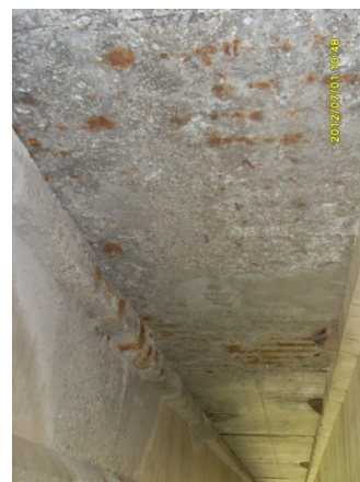
Abb. 78: Fahrbahnplatte: Wasserdurchtritt
