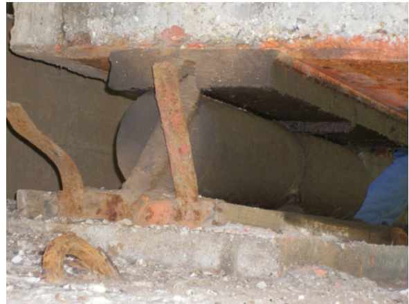
Abb. 72: Lager: Korrosion
