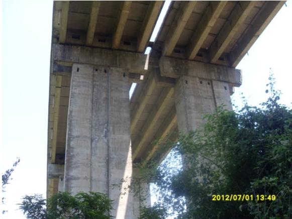
Abb. 69: Pfeiler: Abplatzungen
