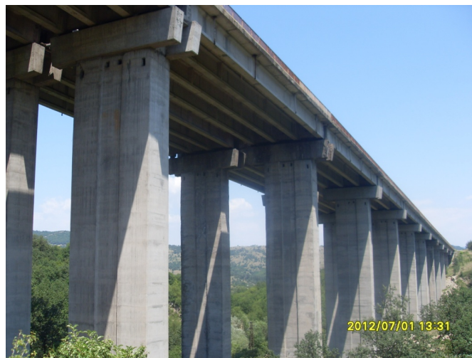
Abb. 1: Balkenbrücke auf der Autobahn Trakija 5
