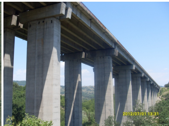
Abb. 68: Viadukt Varschilata: Ansicht
