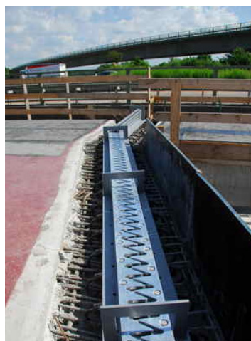
Abb. 28: Übergangskonstruktion mit sinusförmiger Abdeckung 52
