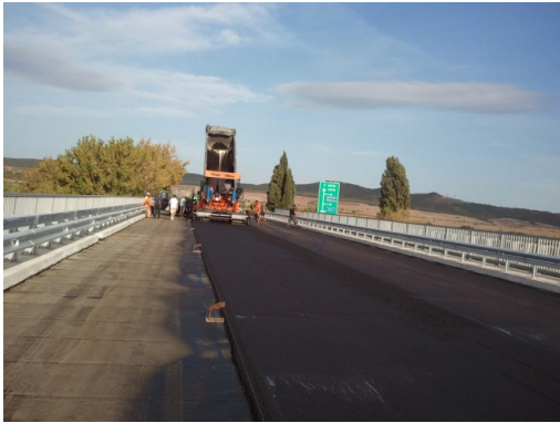
Abb. 45: Neue Abdichtung und Asphaltdecke
