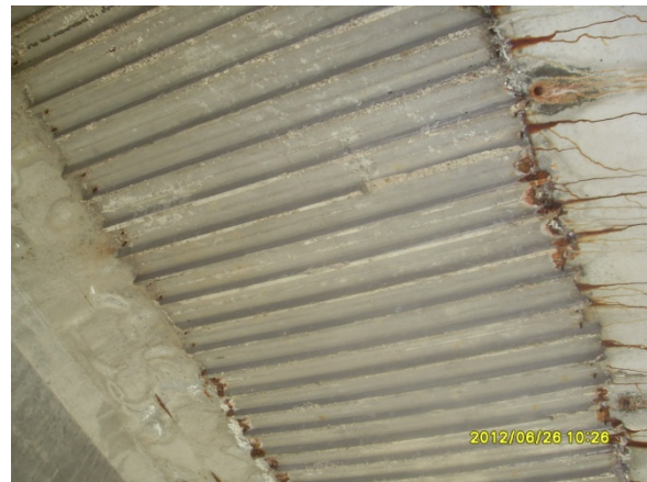
Abb. 58: Fahrbahnplatte: Wasserdurchtritt
