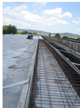
Abb. 44: Errichtung eines neuen Randstreifens
