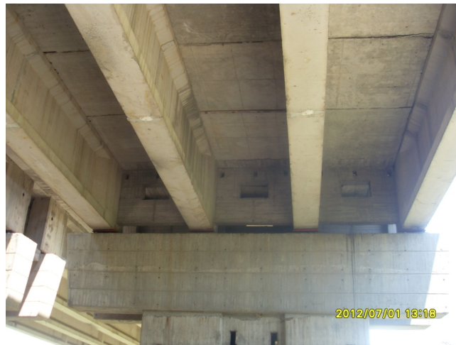
Abb. 5: Plattenbalkenbrücke auf der Autobahn Trakija 11
