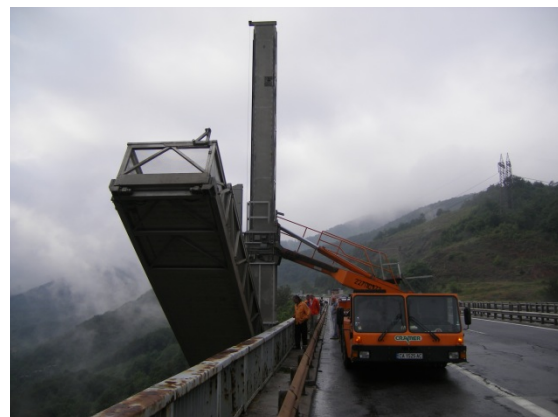
Abb. 19: Teleskopkran mit Arbeitsbühne 33
