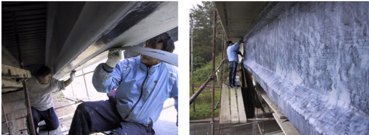
Abb. 49: Anbringung von CFK-Lamellen 100
