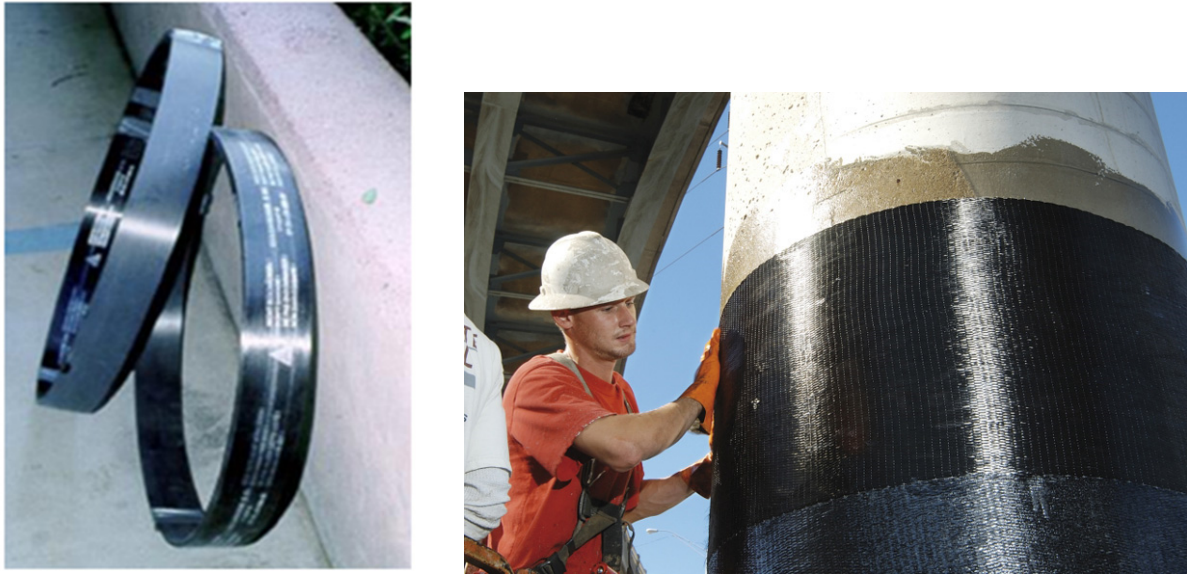
Abb. 48: CFK-Lamellenrolle (links); Aufbringen einer CFK-Matte (rechts) 99
