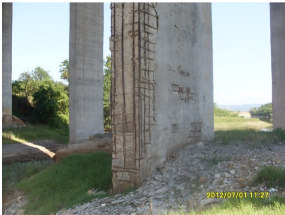
Abb. 81: Pfeiler: Abplatzungen
