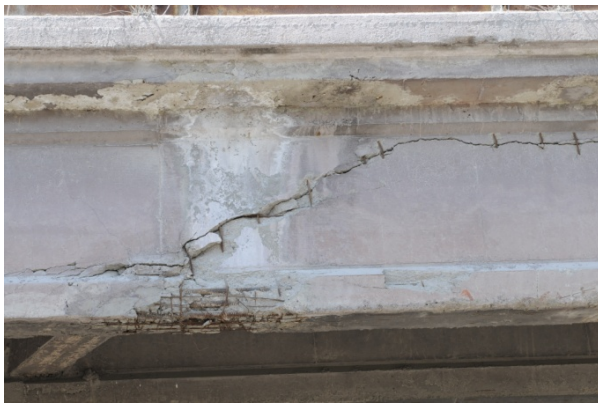
Abb. 89: Anprallschaden: Träger 1
