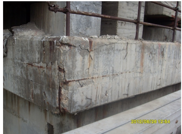
Abb. 64: Riegel: Abplatzungen
