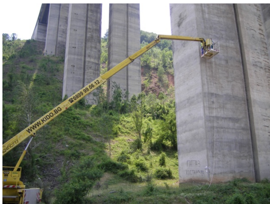
Abb. 18: Teleskopkran mit Arbeitskorb 32
