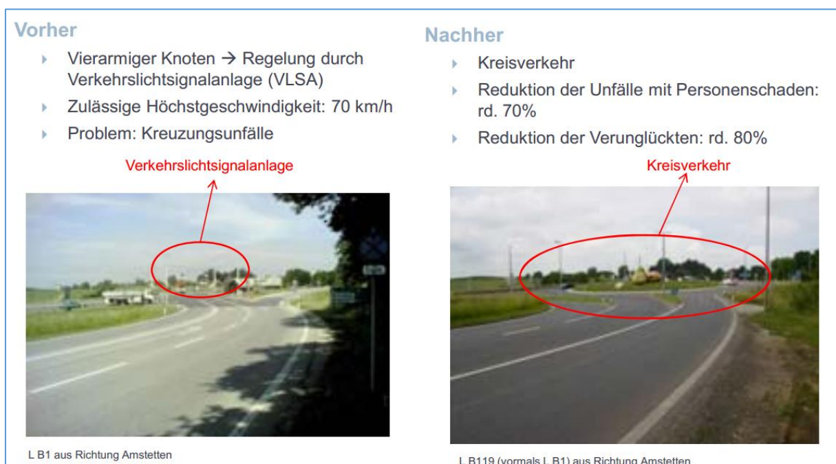
Abbildung 4.3 - Beispiel UHS-Sanierung NÖ L B1 km 134,030 bis km 134,130, 2009 101
