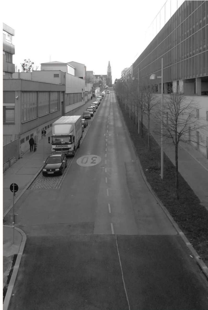
Ab.17 Kendlerstraße als Sichtachse auf Breitenseer Kirche | leere Flucht an der Parkgarage
