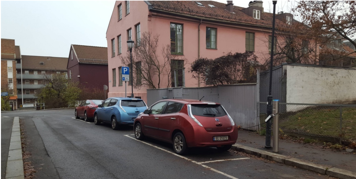
Abbildung 49: Bauliche Lösung Ladeinfrastruktur bestehendes Wohngebiet (eigene Aufnahme, 18.11.2015, Stolmakergata, Oslo)
