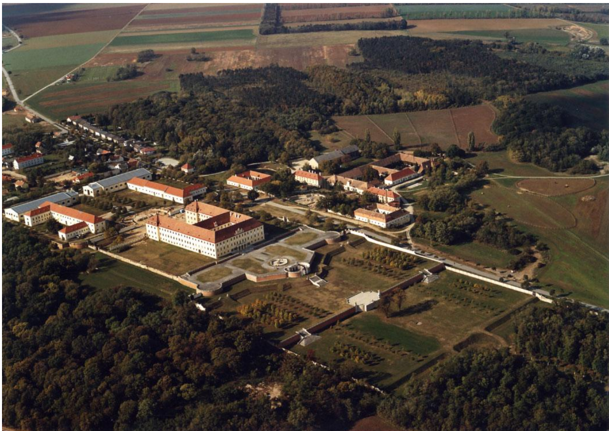
ABBILDUNG 79 - LUFTAUFNAHME SCHLOSS HOF AM BEGINN DER RESTAURIERUNGSARBEITEN, 2003
