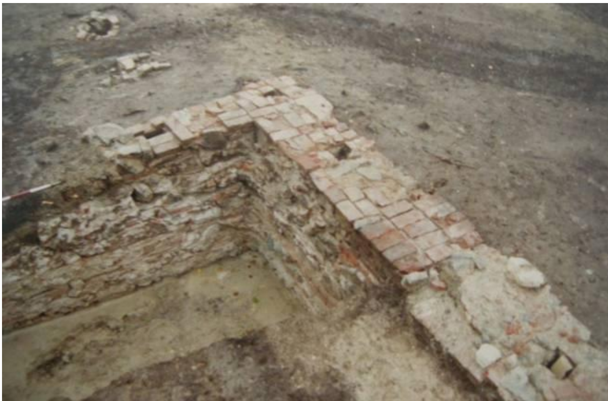
ABBILDUNG 94 - DETAILFOTO GRABUNGEN 1992, FUNDAMENTECKE PAVILLON
