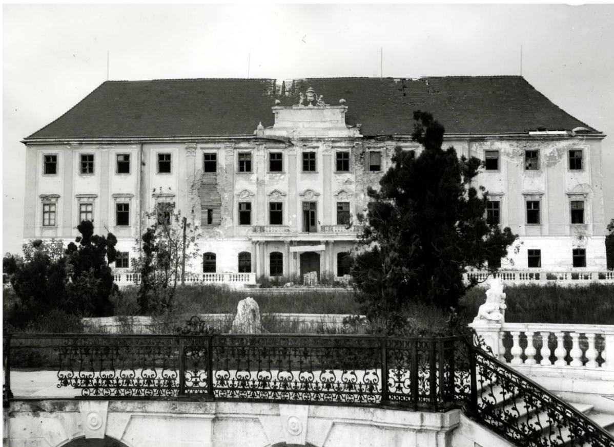
ABBILDUNG 78 - ANSICHT VON DER OSTSEITE MIT KRIEGSSCHÄDEN, HISTORISCHES FOTO
