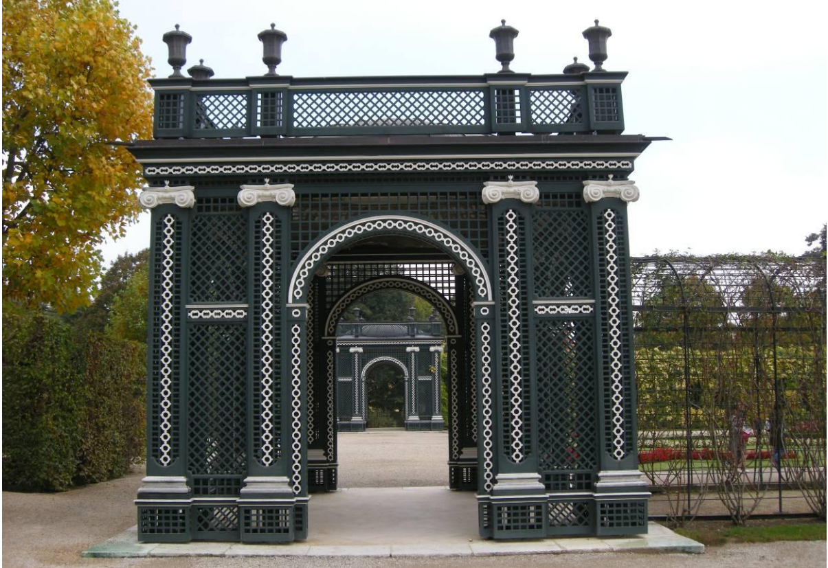
ABBILDUNG 44 - PAVILLON HIETZINGER KAMMERGARTEN, ZUSTAND NACH DER RESTAURIERUNG, 2010
