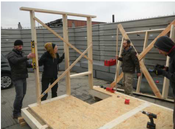
3.86 Montage der Wände - W3
