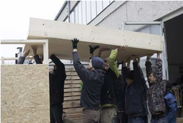
3.100 aufsetzen der Decke
