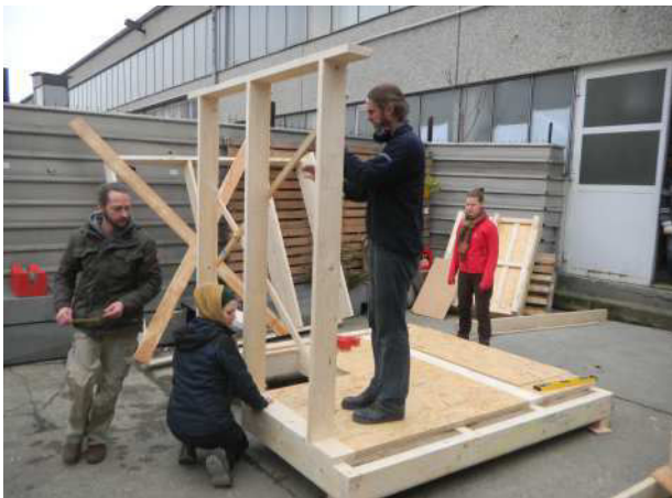
3.85 Montage der Wände - W3
