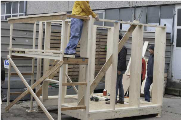
3.87 Montage der Wände
