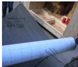
3.19 Winddichtbahn
