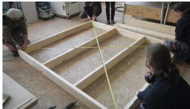
3.66 ausmessen der Diagonalen
