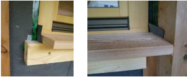
3.228 + 3.229 EPDM-Folie unterhalb dem Fensterbrett
