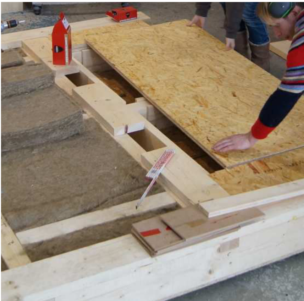
3.53 OSB-Platten im Gefälle, für Loggia
