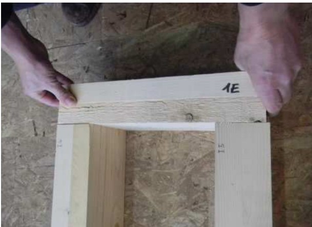
3.42 überprüfen ob richtig gearbeitet wurde
