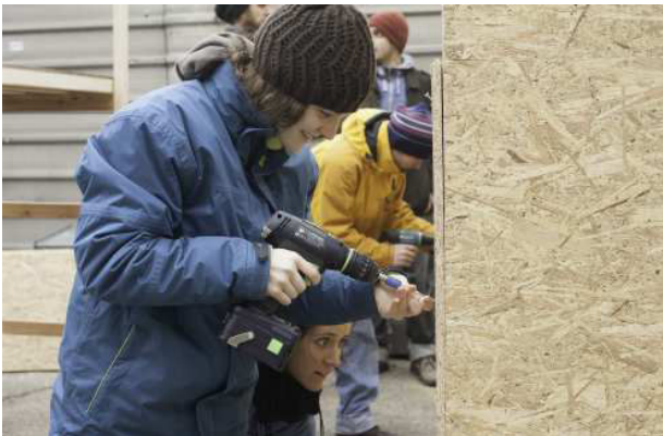
3.96 beplanken der Wände
