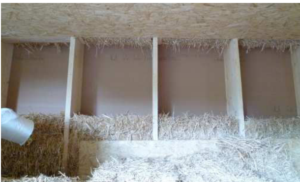
3.121 teilweise befüllte Wände
