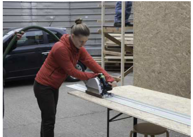
3.147 beplanken der Decke
