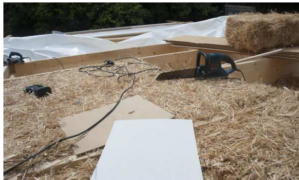
3.179 Dachdämmung mit Strohballen
