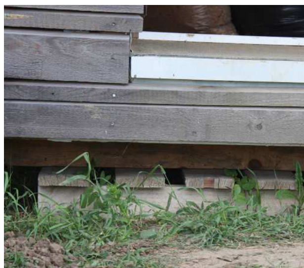
3.61 Paletten als Fundament
