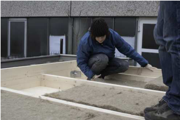
3.150 dämmen der Decke
