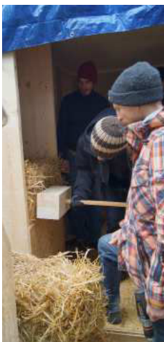
3.122 + 3.123 verdichten und füllen einer Wand
