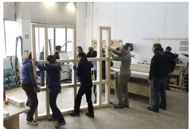
3.45 die Bodenplatte wird herum gedreht
