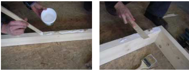
3.75 + 3.76 verleimen der Aufdopplung..
