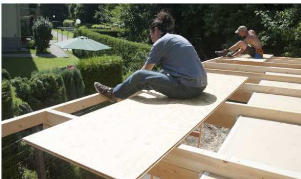
3.185 Hinterlüftungsebene
