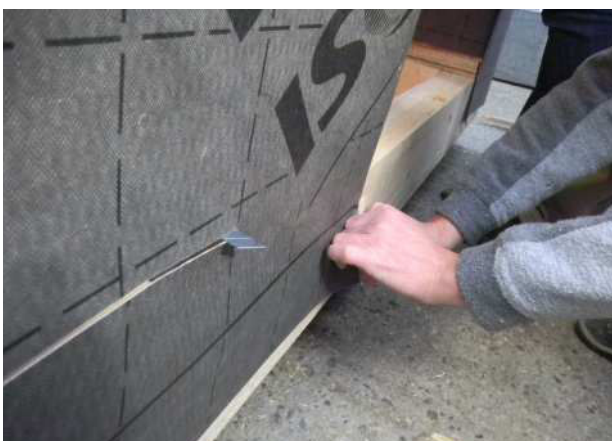
3.108 nachträgliches ausschneiden der Öffnungen
