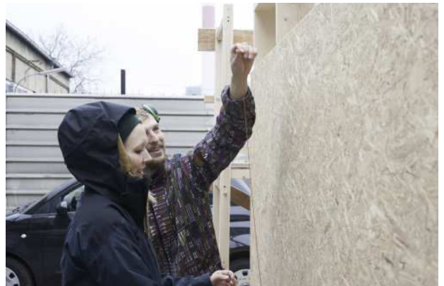
3.98 Position der Steher mittels Schlagschnur markieren
