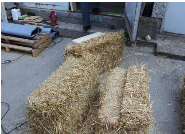
3.114 Strohballen herrichten - Nut ausschneiden
