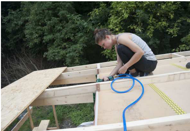
3.183 Insektenschutzgitter bei der Hinterlüftungsebene
