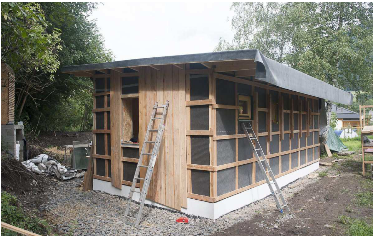
3.192 Folie fertig verklebt
