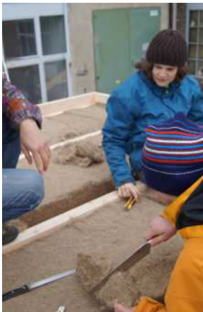
3.145 dämmen der Decke
