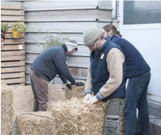
3.113 Strohballen herrichten - Rundungen begradigen
