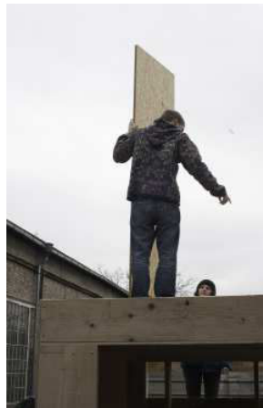
3.146 beplanken der Decke
