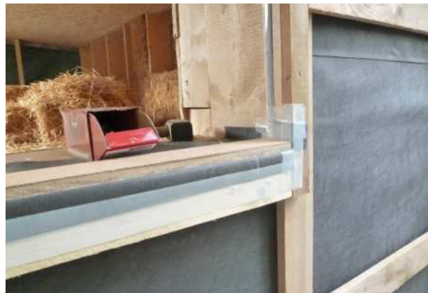
3.238 Konstruktionsholz als Unterkonstruktion für das Fensterbrett
