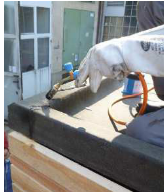
3.161+ 3.162 Dachabdichtung mittels Bitumenbahn
