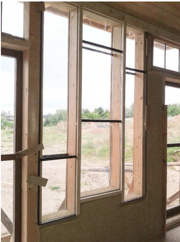
3.262 Glasfassade „Haus von A bis Z“ Innenansicht
