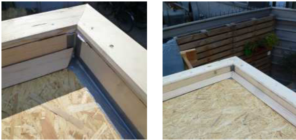
3.154 + 3.155 Keilholz und Dreiecksleisten der Attika
