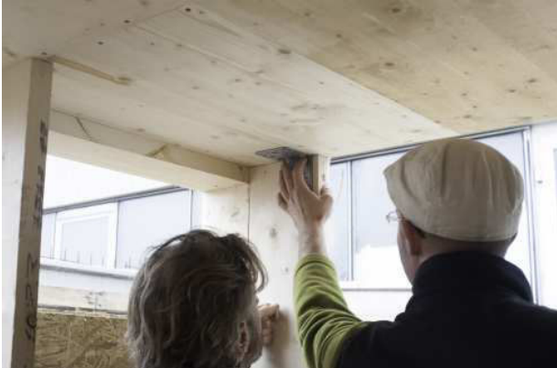
3.94 befestigen der Deckenplatte
