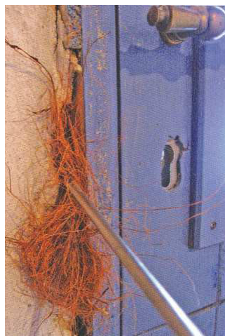
3.220 Fuge mittels Dämmmaterial ausstopfen
