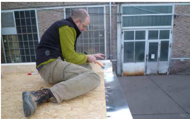
3.157 Montage des Abschlussblech für Tropfkante
