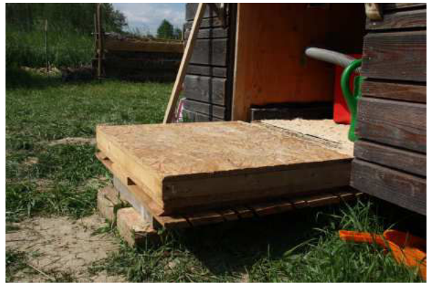
3.336 Klappe zum Wechseln der Behälter
