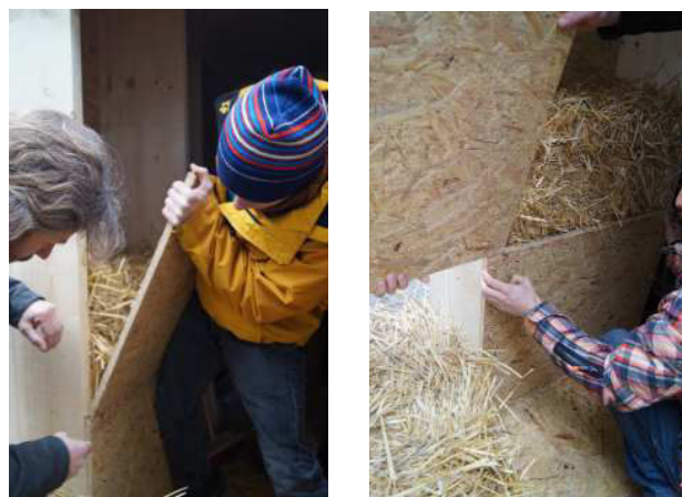
3.133 + 3.134 verplanken der Strohballenwände
