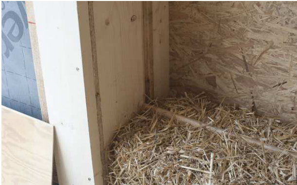
3.119 links „Schuhlöffel“, Leiste zum Fixieren
