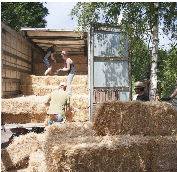
3.16 Lieferung von Strohballen
