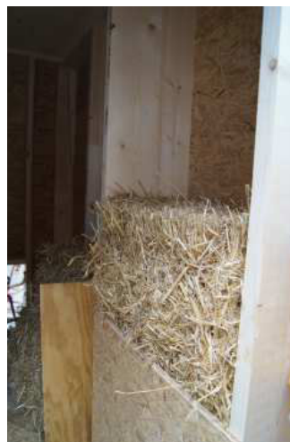
3.122 + 3.123 verdichten und füllen einer Wand
