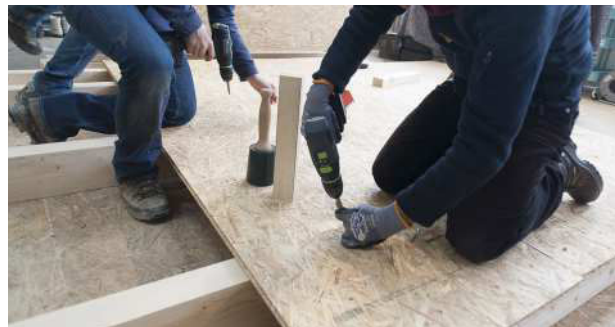
3.46 festschrauben der OSB-Platten
