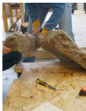
3.49 schneiden der Hanfwolle mit dem Küchenmesser
