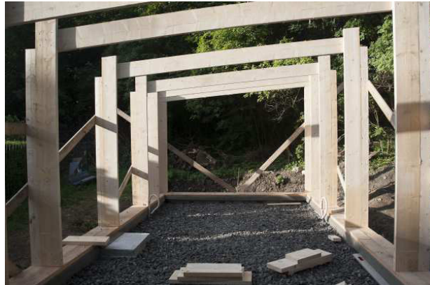
3.177 Rahmenkonstruktion der Wände
