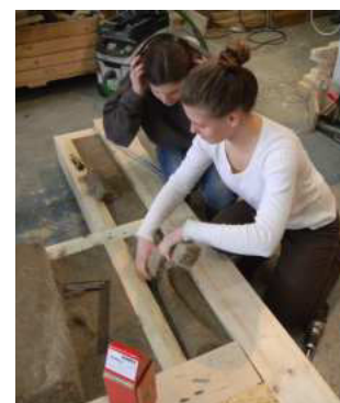
3.50 ausstopfen der Bodenplatte mit Hanfwolle
