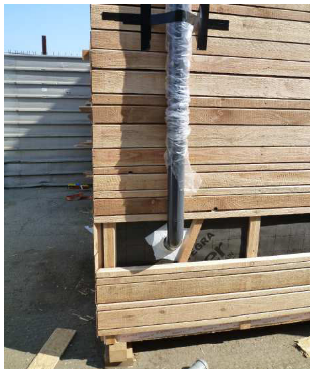
3.136.6 Durchdringungen durch Strohballenwände
