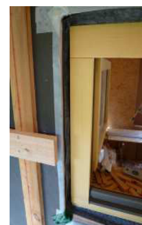
3.214 Winddicht-Klebeband
