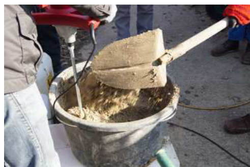
3.285 mischen mit Baustellenmischer
