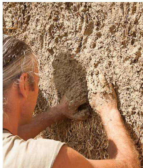
3.295 direkt verputzen von Strohballen
