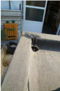
3.161+ 3.162 Dachabdichtung mittels Bitumenbahn
