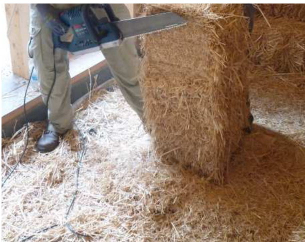
3.115 Strohballen herrichten - Nut ausschneiden
