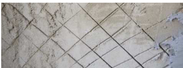
3.308 erste Putzschicht, eingeritzt
