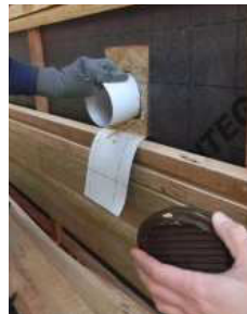
3.136.3 + 3.136.4 Durchdringungen durch Strohballenwände
