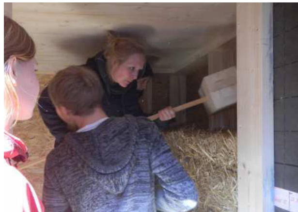
3.125 verdichten der Strohballen mittels Persuader
