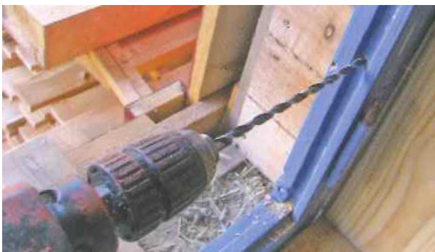
3.217 vorbohren der Schraublöcher
