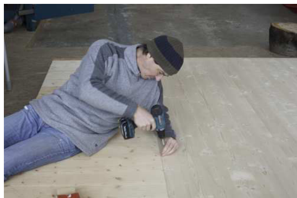
3.144 Montage der Dreischichtplatte als Deckenunterseite
