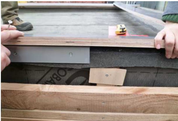
3.170 Montage Attika-Siebdruckplatte
