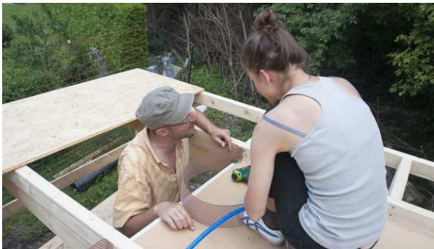
3.184 Insektenschutzgitter an trackern
