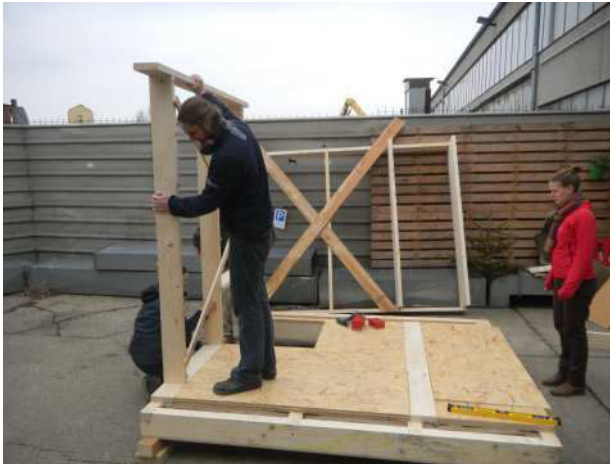
3.84 Montage der Wände - W3
