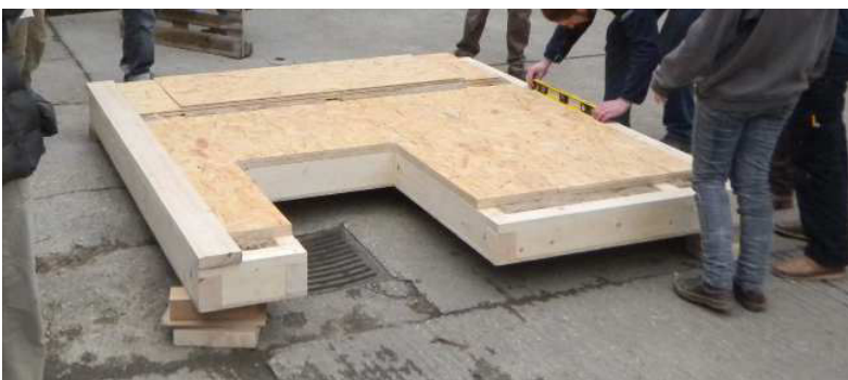
3.59 ..und in Waage gebracht
