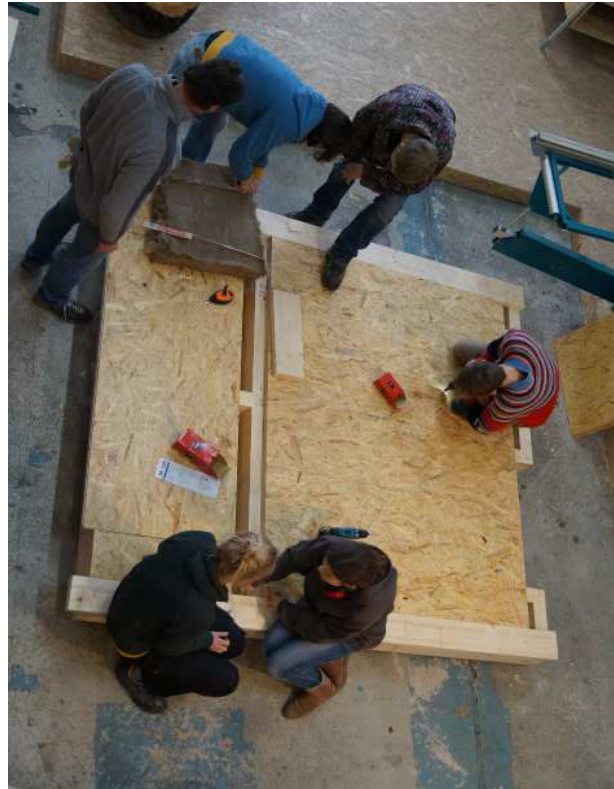
3.55 fixieren der OSB-Platten
