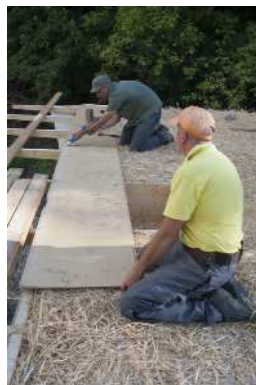
3.180 + 3.181 Dachdämmung mit Strohballen
