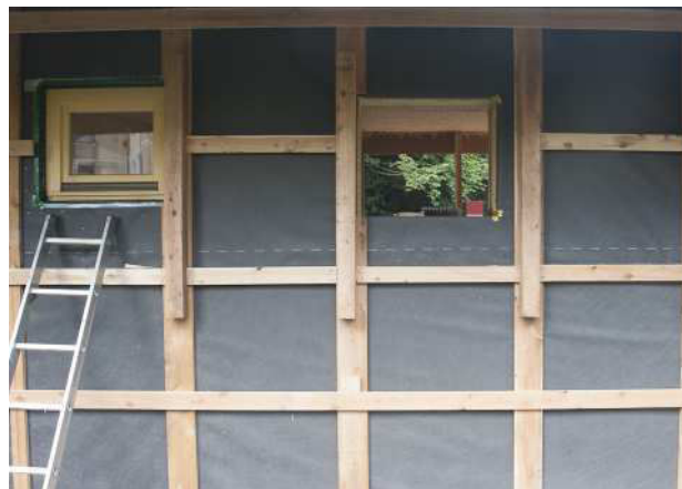
3.212 Laibungen winddicht verklebt
