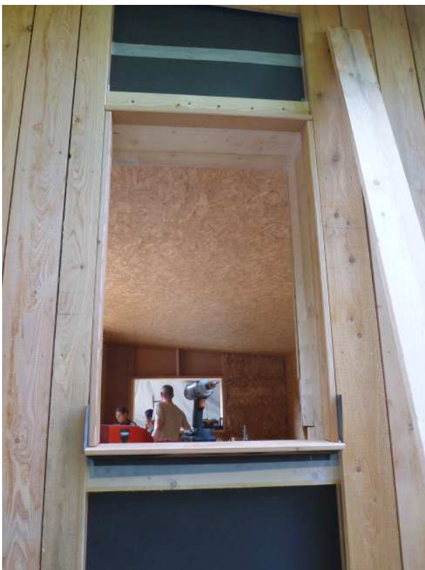
3.247 fertige Laibungsverkleidung
