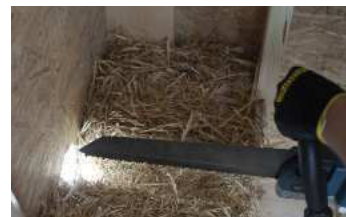
3.136.1 + 3.136.2 Durchdringungen durch Strohballenwände
