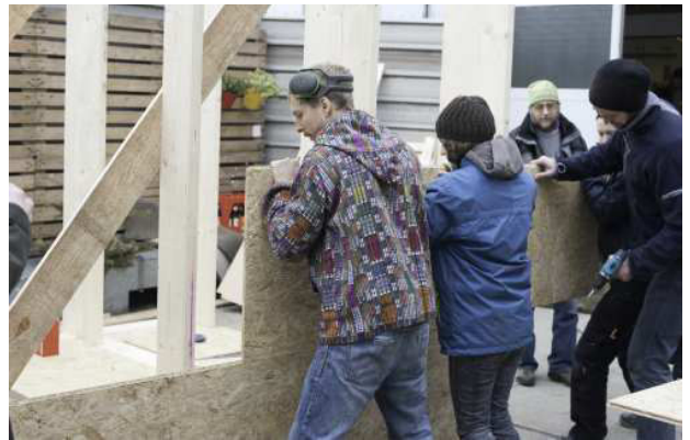
3.97 beplanken der Wände
