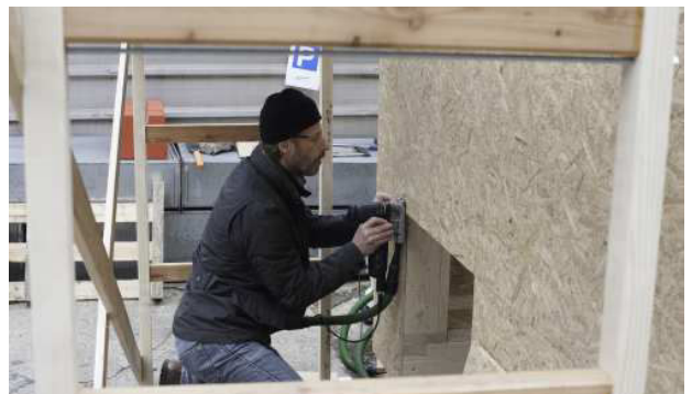
3.99 nachträgliches Ausschneiden der Öffnungen
