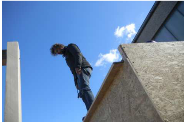
3.151 die OSB-Platten ragen auf der Rückseite 2cm vor die fertige Fassade, damit das Wasser gut abgeleitet wird
