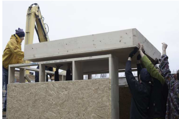
3.101 aufsetzen der Decke
