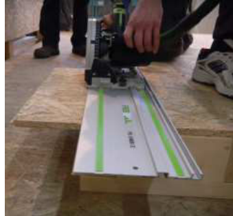
3.51 + 3.52 überstehende OSB-Platten werden nachträglich abgeschnitten
