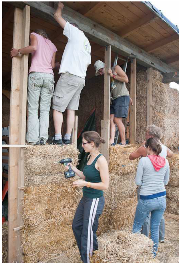
3.124 verdichten der Strohballen mittels Körpergewicht
