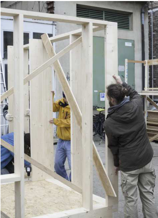
3.90 Montage der Wände
