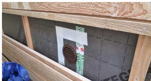
3.136.5 Durchdringungen durch Strohballenwände
