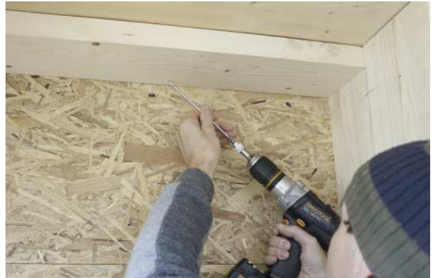
3.95 befestigen der Deckenplatte
