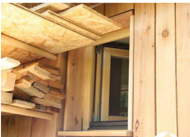
3.232 Fenster verkleidet in fertiger Fassade
