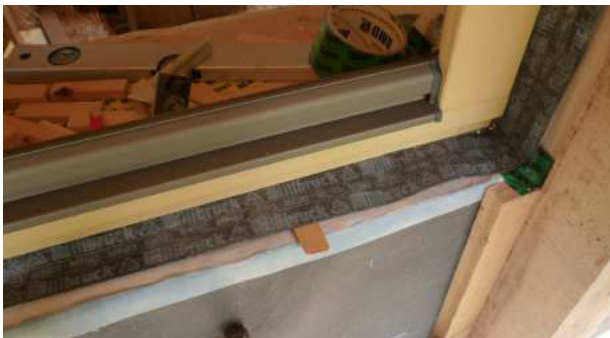
3.215 Fensterkeil und Klebebahn
