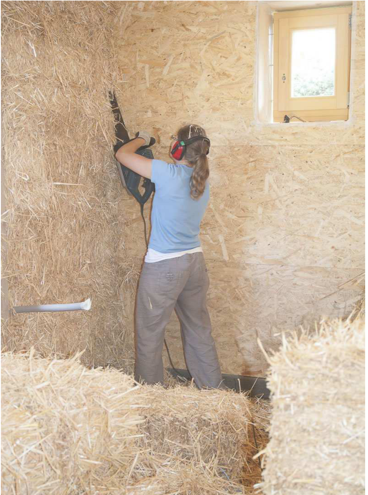
3.135 abscheren der fertigen Wand
