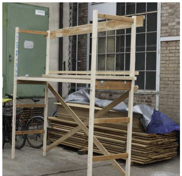
3.24 Gerüst Marke Eigenbau
