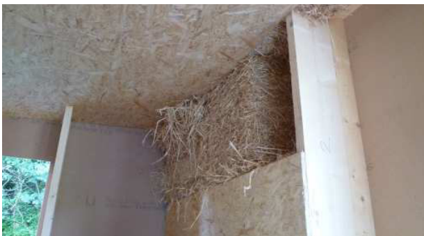
3.120 teilweise befüllte Wände
