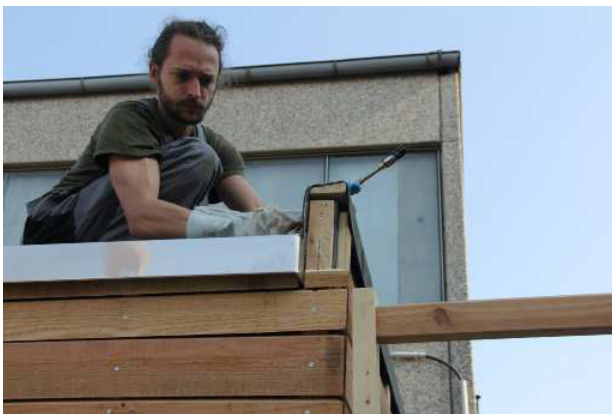
3.163 Dachabdichtung mittels Bitumenbahn
