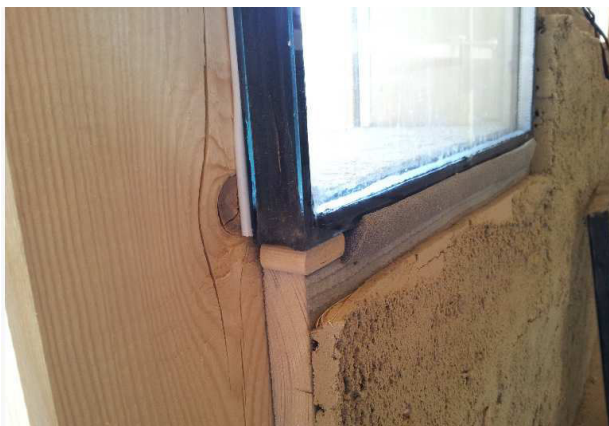
3.264 Holzklötzchen zwischen Kompriband
