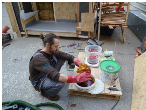
3.205 mischen der Komponenten von Kemperol 2k Pur
