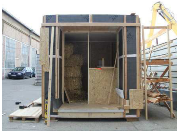
3.268 erste Fassadenlatte oberhalb der Loggia
