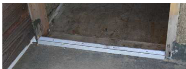
3.206 fertige abgedichtet und abgesandet
