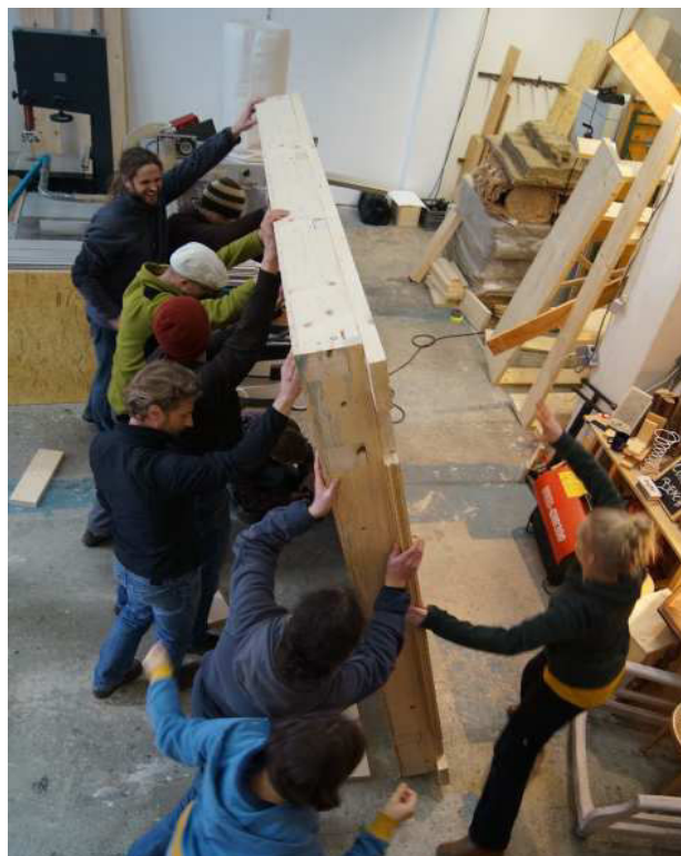
3.56 umdrehend der Bodenplatte
