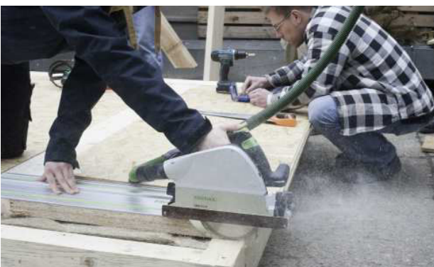
3.92 Korrektur der Auspraungen in der Bodenplatte
