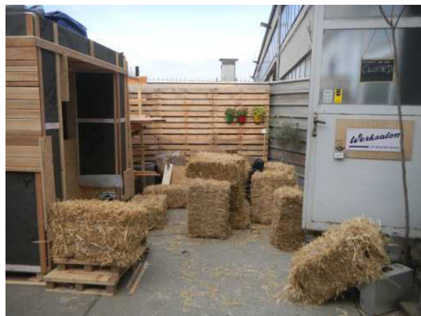
3.111 Stroh am Bauplatz
