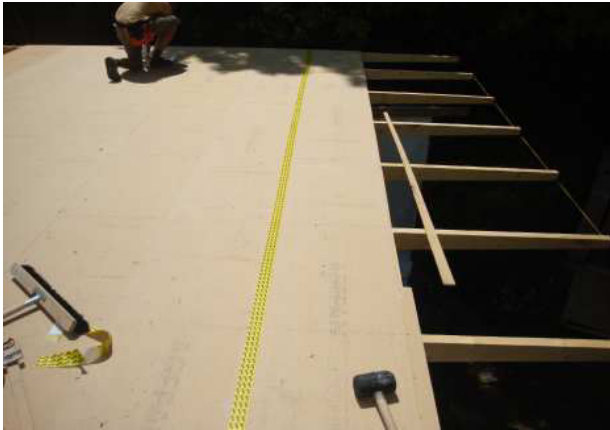
3.182 Agepan-Platten oberhalb der Ballen
