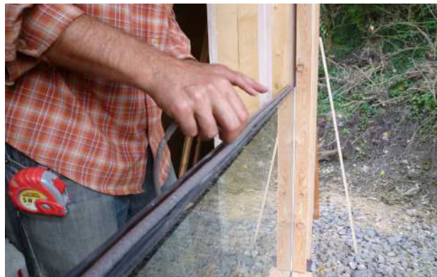
3.251 Fugenband rund zwischen zwei Glasscheiben
