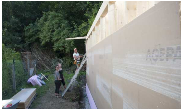
3.178 Agapanplatten Wände
