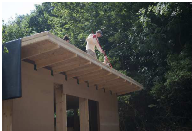
3.187 Kleber mit dem Malerroller auftragen
