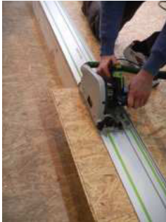
3.51 + 3.52 überstehende OSB-Platten werden nachträglich abgeschnitten
