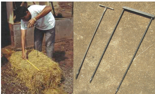
3.137 Teilen von Strohballen mittels Strohballennadel
