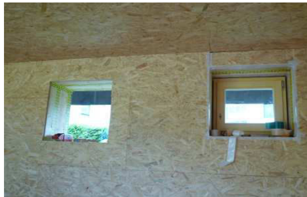
3.211 Laibungen winddicht verklebt
