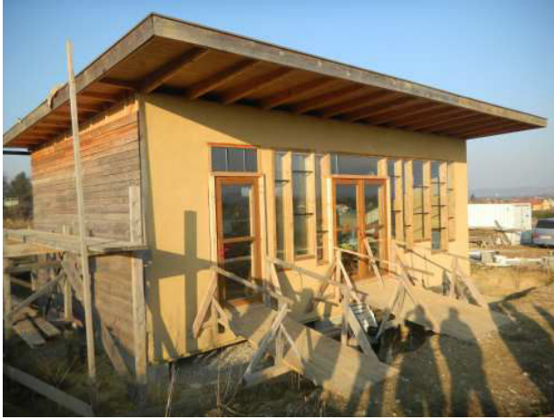
3.261 Glasfassade „Haus von A bis Z“
