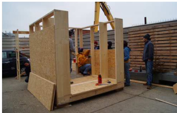
3.91 Korrektur der Wände
