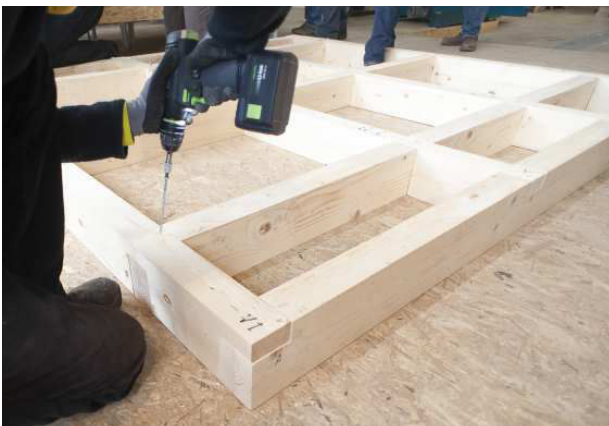
3.44 festschrauben der Verbindungen
