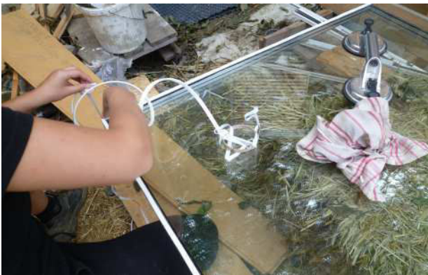
3.250 Dichtbänder für Fenster
