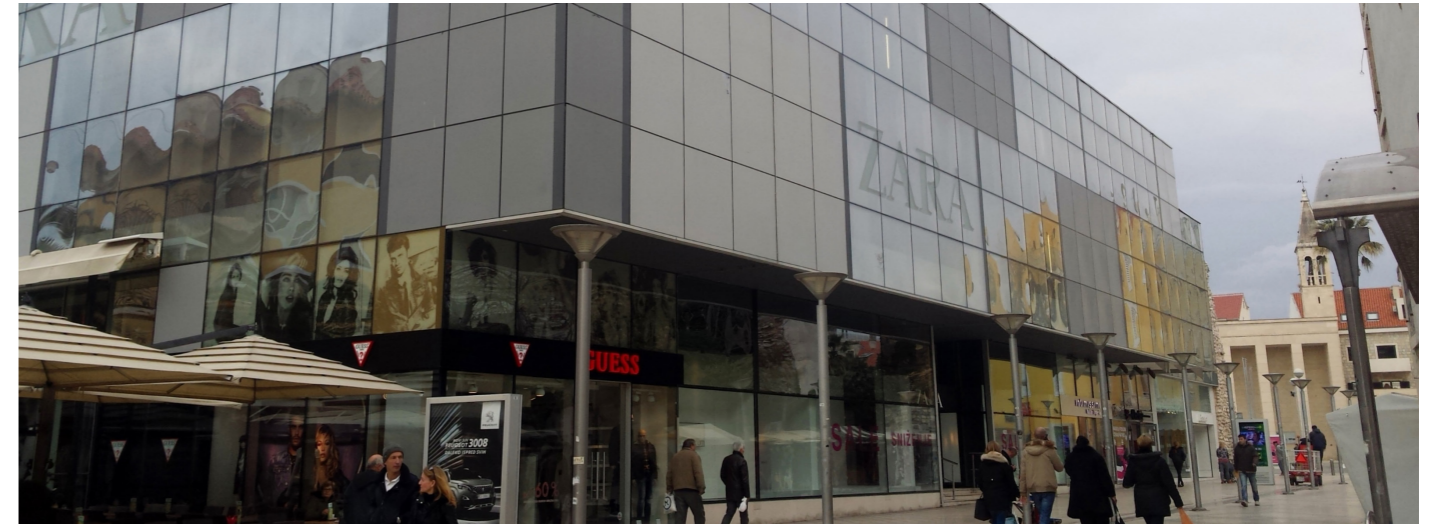
Abb. 40 Das Kaufhaus nach der Umgestaltung, 2017
