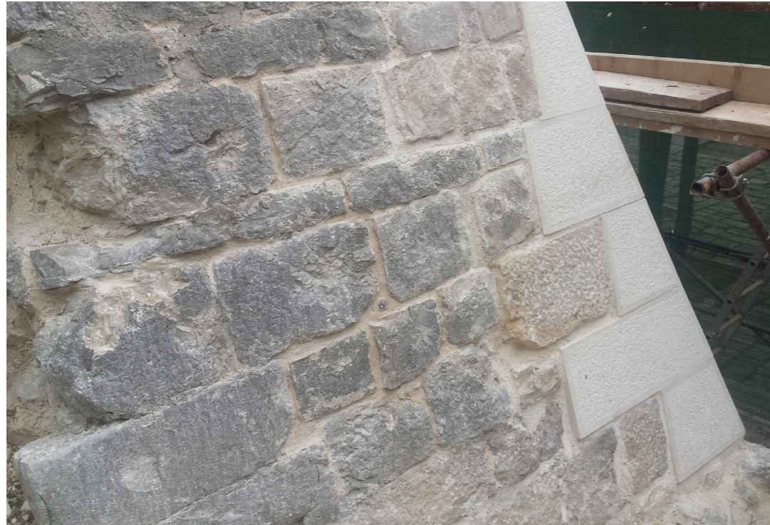
Abb. 63 Instandsetzung des Steinmantels
