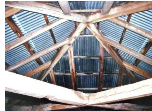
Abb. 219 Dachkonstruktion des mittleren Traktes
