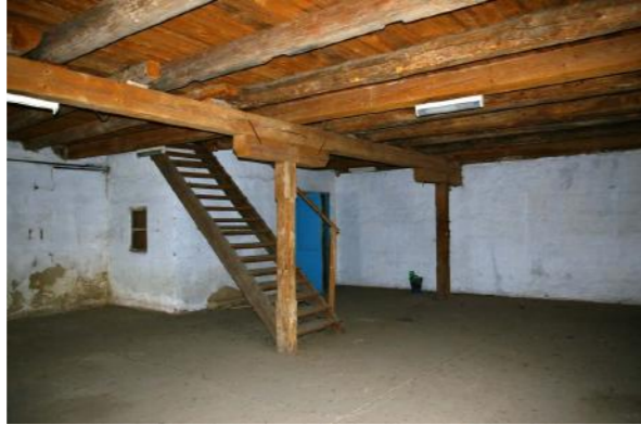
Abb. 37 Die Holzkonstruktion des Erdgeschosses
