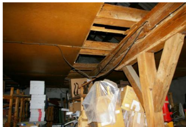
Abb. 67 Tragbalken des Obergeschosses (K-06)
