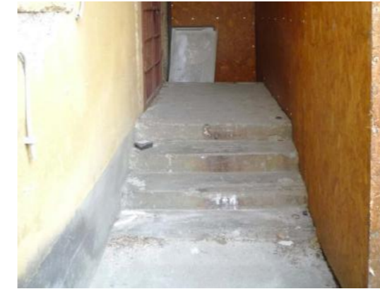
Abb. 55 Treppe vor der Eingangstür
