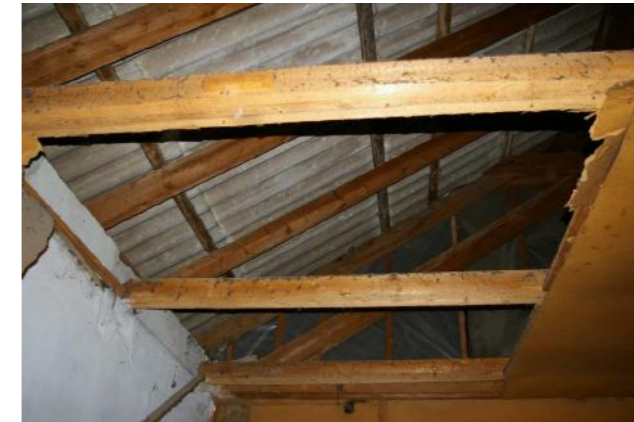
Abb. 40 Nachträglich gebaute Balken mit Holzfaserplatte
