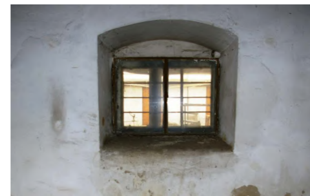
Abb. 41 Fenster mit Segmentbogen
