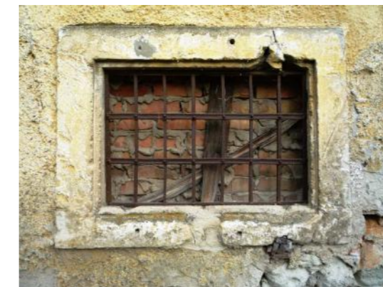
Abb. 56 Gitter eines zugemauerten Fenster
