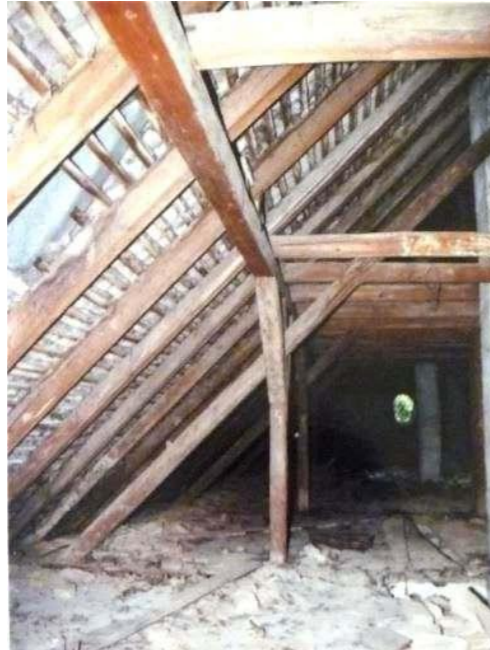
Abb. 112 Teil des Pfettendaches mit dem Dachstuhl
