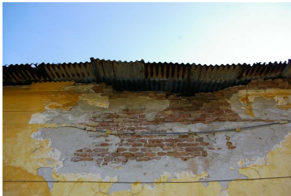
Abb. 228 Sichtbares Mauerwerk an der westlichen Seite des Gebäudes
