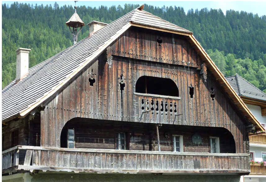
Abb. 106 Ansicht Gank im Sommer 2016
