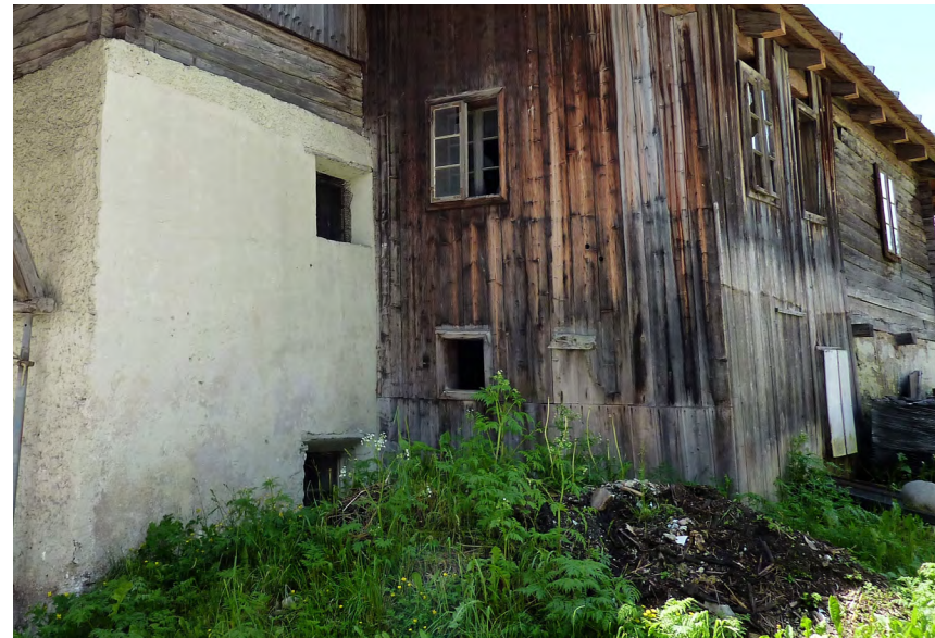
Abb. 74 Außenansicht Trockentoilette und Schacht
