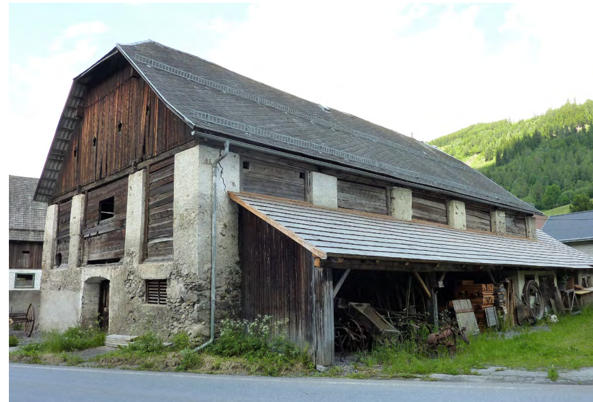
Abb. 56 Stallgebäude Ansicht Süd und Ost
