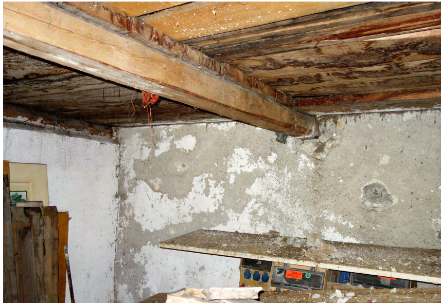
Abb. 119 Innenansicht ehemalige Mühle
