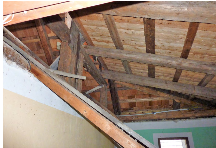
Abb. 100 Herabgestürzte Decke
