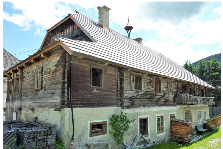
Abb. 52 Wohnhaus Ansicht West mit dem Anbau im Norden
