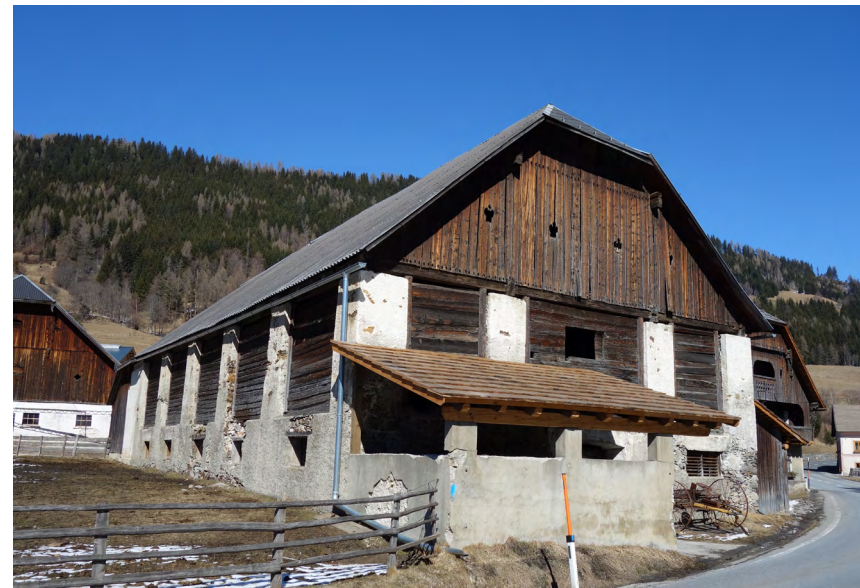
Abb. 145 Saniertes Dach vom Anbau
