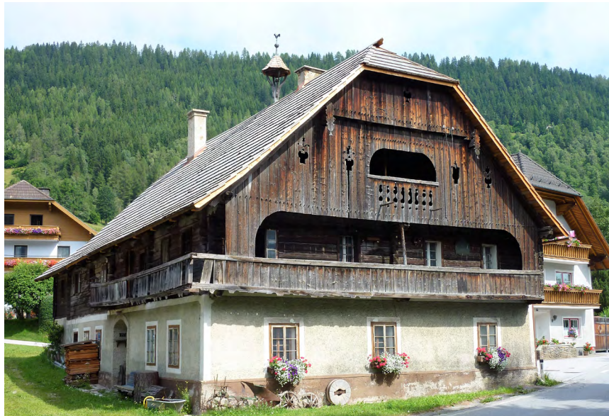
Abb. 46 Wohnhaus Ansicht Süd
