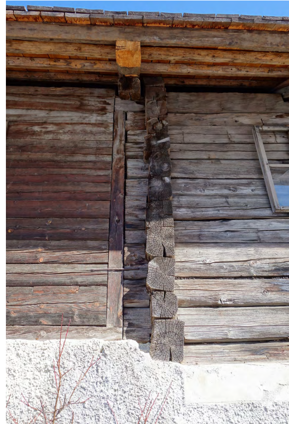
Abb. 51 Westfassade mit dem nachträglichen Anbau auf der linken Seite
