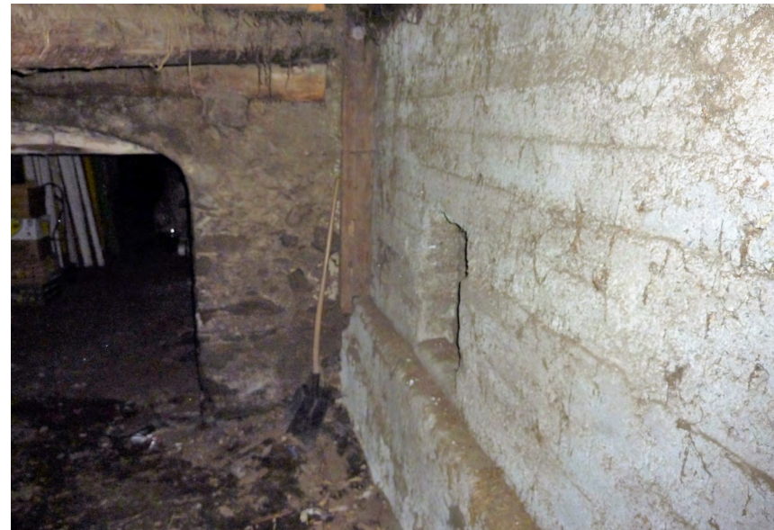
Abb. 125 Stalleinfahrt mit Silowand
