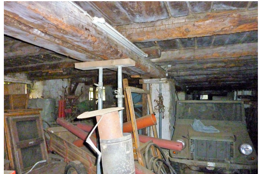
Abb. 147 Abgestützte Decke im Stall
