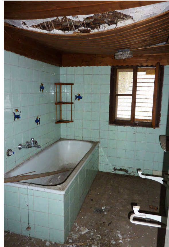
Abb. 103 Innenansicht Bad im Juli 2016
