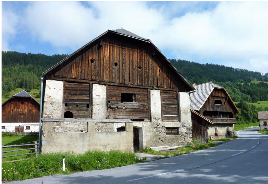
Abb. 44 Stallgebäude Ansicht Süd, rechts davon das Wohnhaus
