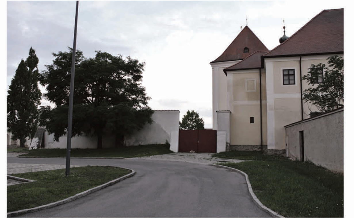
Abbildung 21: Alte Friedhofsmauer und Gartentrakt, Ostansicht
