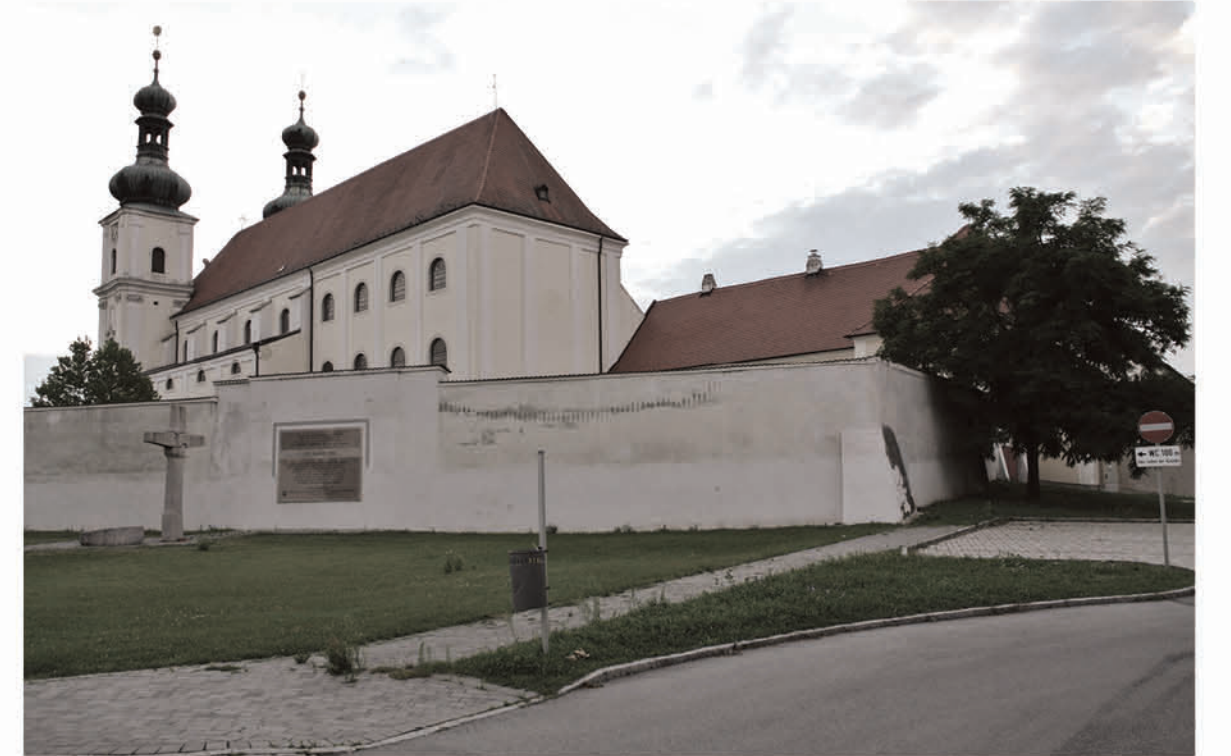
Abbildung 20: Alte Friedhofsmauer und Basilika, Südostansicht
