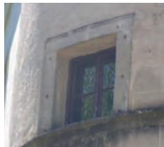
VIII AUSSENMAUER RUNDTURM
