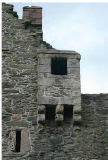
FOTO.2.3: WEHRERKER ÜBER DEM BURGEINGANG
