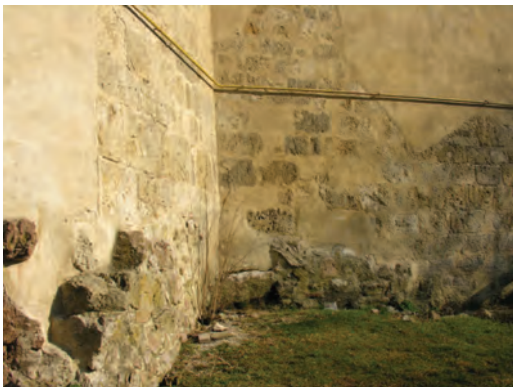
III DETAIL DER BURGMAUER
