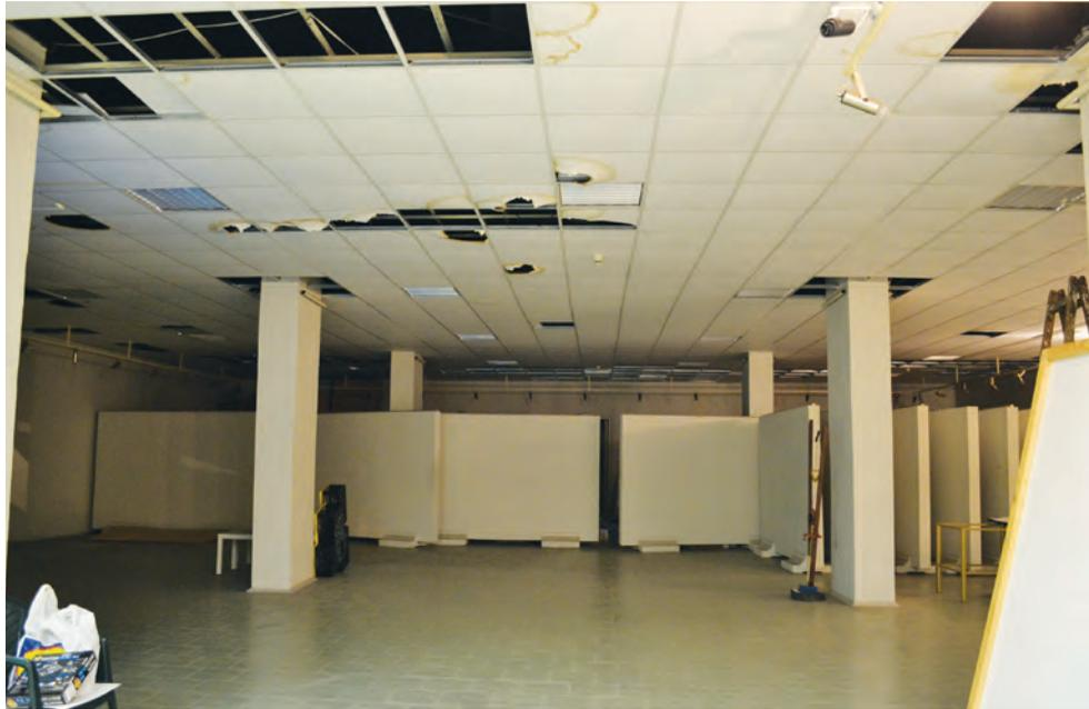
Abb.105. Kunstgalerie Russe – Ausstellungsraum Untergeschoss, Schäden auf der abgehängten Decke
