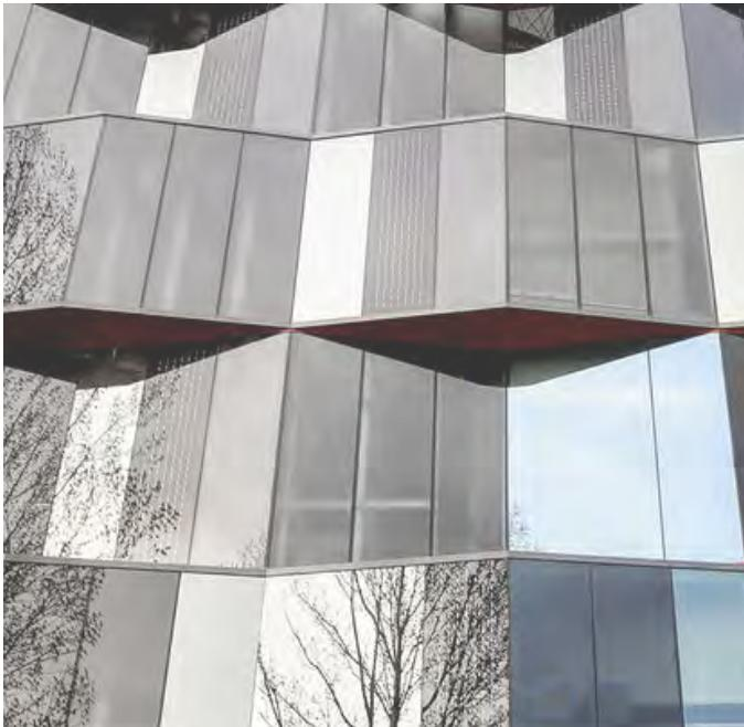
Abb.154. Integrierte Photovoltaikpanelen- Solarfassade
