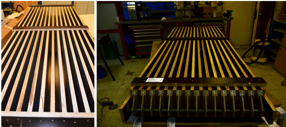
(a) Schalung für 15 Versuchsträger
