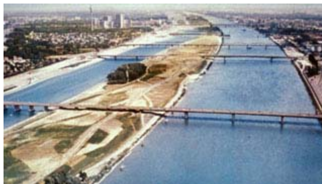
Abbildung 4: Neue Donau, Donauinsel und Donau während des Bauzustands (Blick stromabwärts) [15]
