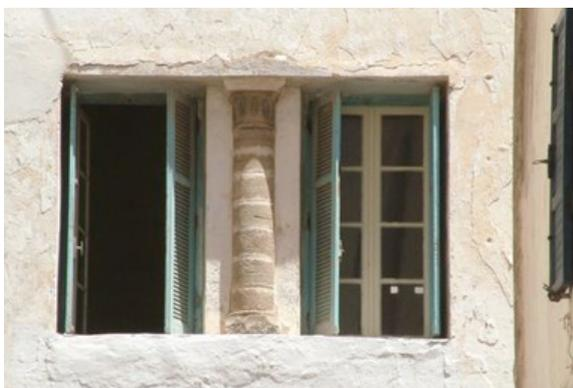
Abbildung 212: Doppelfenster mit Mittelstütze ohne Rahmenausbildung
