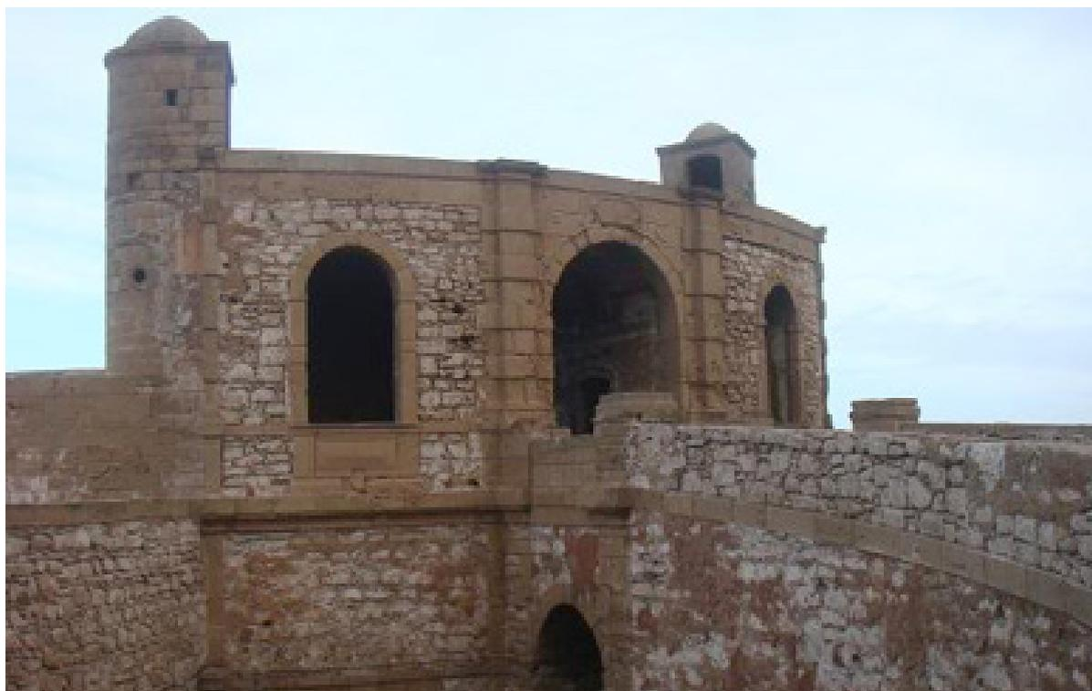
Abbildung 114: Bastion im Norden auf der Sqala im europäischen Baustil mit unterschiedlichen Steinen, Rundbogenöffnungen und Pilastern
