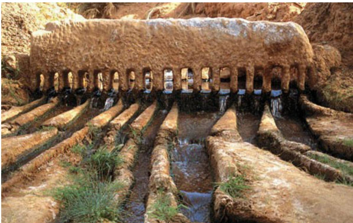
Abbildung 8: Verteilungsgitter einer Qanatanlage mit den unterschiedlichen Wasserableitungen
