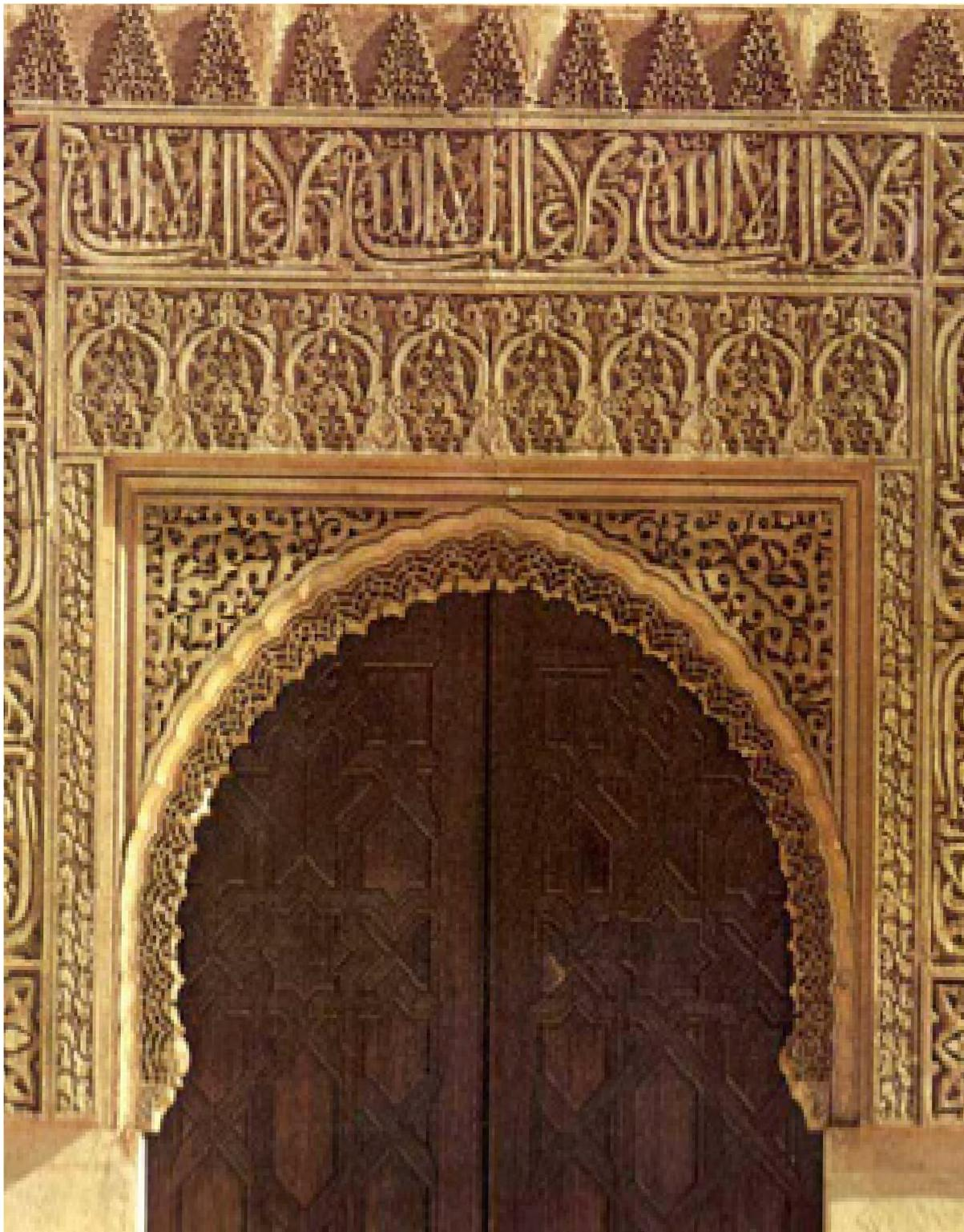
Abbildung 28: Ansicht auf eines der Tore des Comares Palasts mit der Darstellung der islamischen Kalligrafien durch detaillierte Schnitzereien in den Sandsteinelementen und den Holzbauteilen der Fassade
