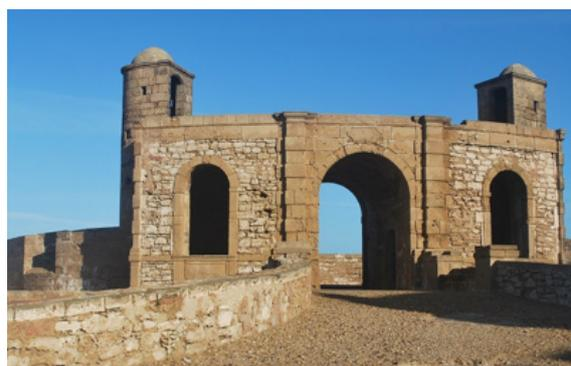
Abbildung 42: Der Torbau der Bastion Nord mit der charakteristischen Steinbauweise und den drei Rundbögen
