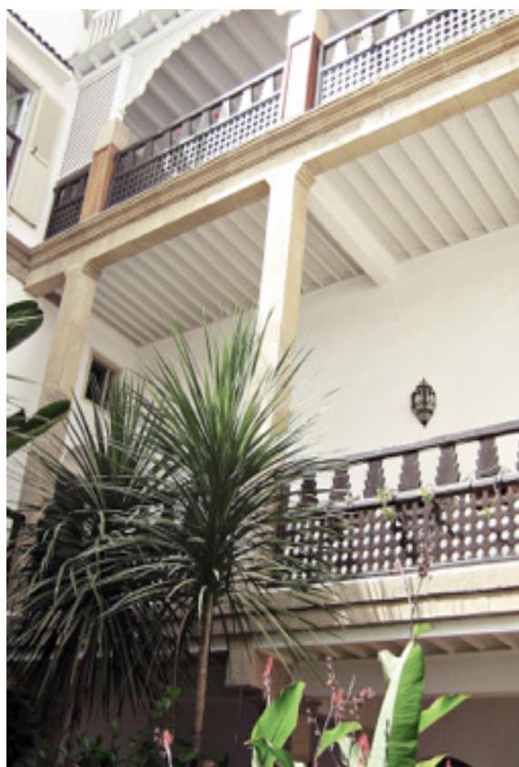
Abbildung 188: Ansicht der Galerie des Hotels Riad Chems Bleu mit rechteckigen Stützen und gitterartigen, hölzernen Brüstungen
