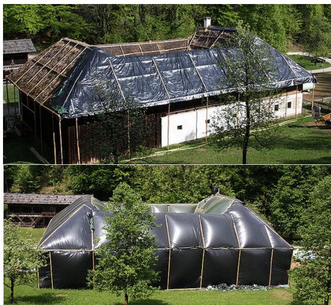
Fig. 3.96. Chemical treatment process in Stübing Freilichtmuseum (Courtesy of Stübing Freilichtmuseum)
