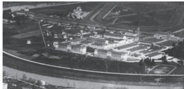
20. LUFTBILDAUFNAHME REGIA FABBRICA D'ARMI Blick auf die Kasernenbauten, um 1919
