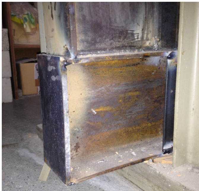
Abb. 3.20: Positionierung der Steifen
