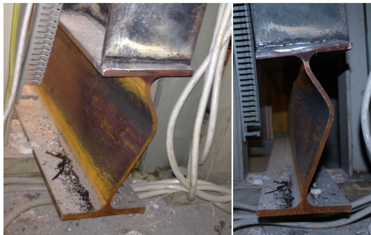
Abb. 3.18: Versagen der Träger durch Beulen
