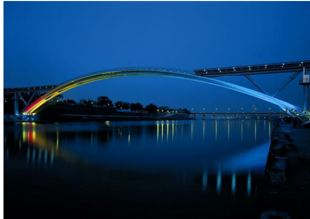
Bild 2.6: Seonyu Fussgängerbrücke aus UHPC in Seoul (3)
