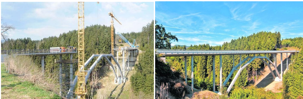
Bild 2.4: Erste Bogenbrücke aus UHPC in Kärnten/Österreich im Bau (13)
