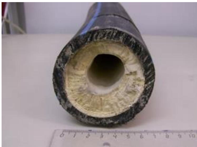
Abb. 35: Versinterung einer Drainage-Rohrleitung (Dietzel et al., 2008b)
