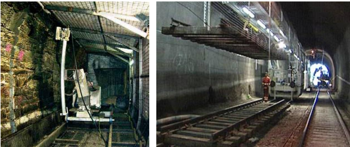
Abb. 25: Links: Hochdruckwasserstrahlen mit Roboter (STUVA, 2011); rechts: Gleisabtrag mittels gleisgebundenem Spezialkran (vbgv1.orf.at)
