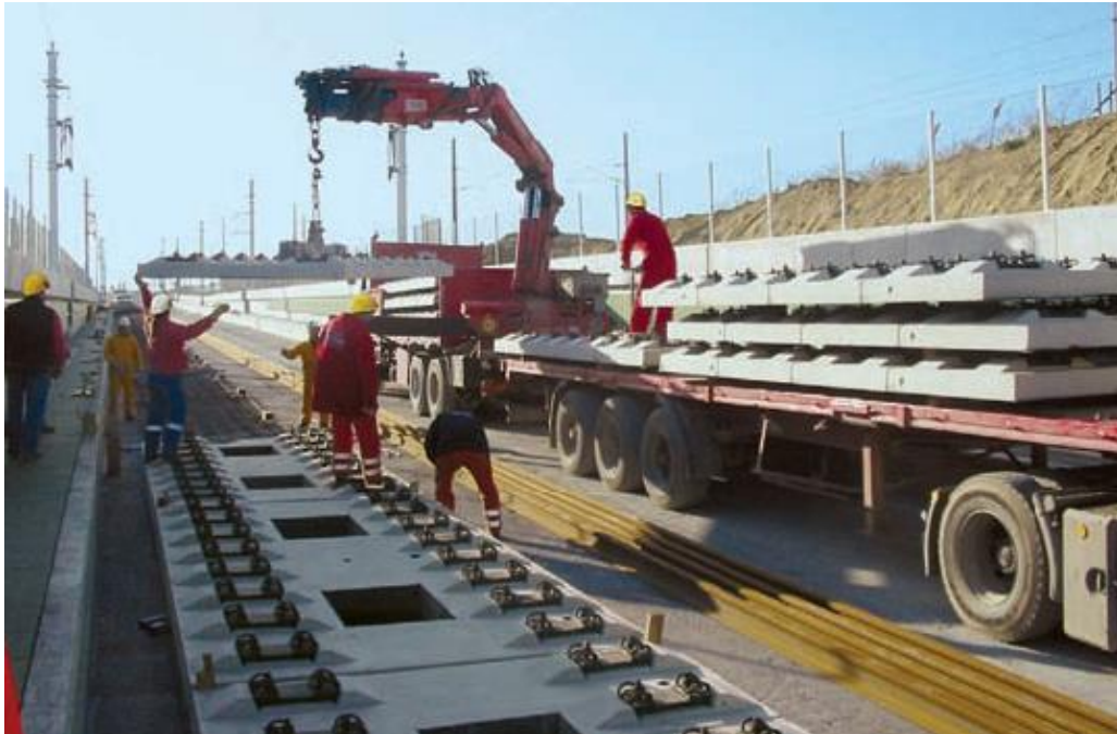
Abb. 19: Verlegung Feste-Fahrbahn-System ÖBB/PORR (Porr, 2009)
