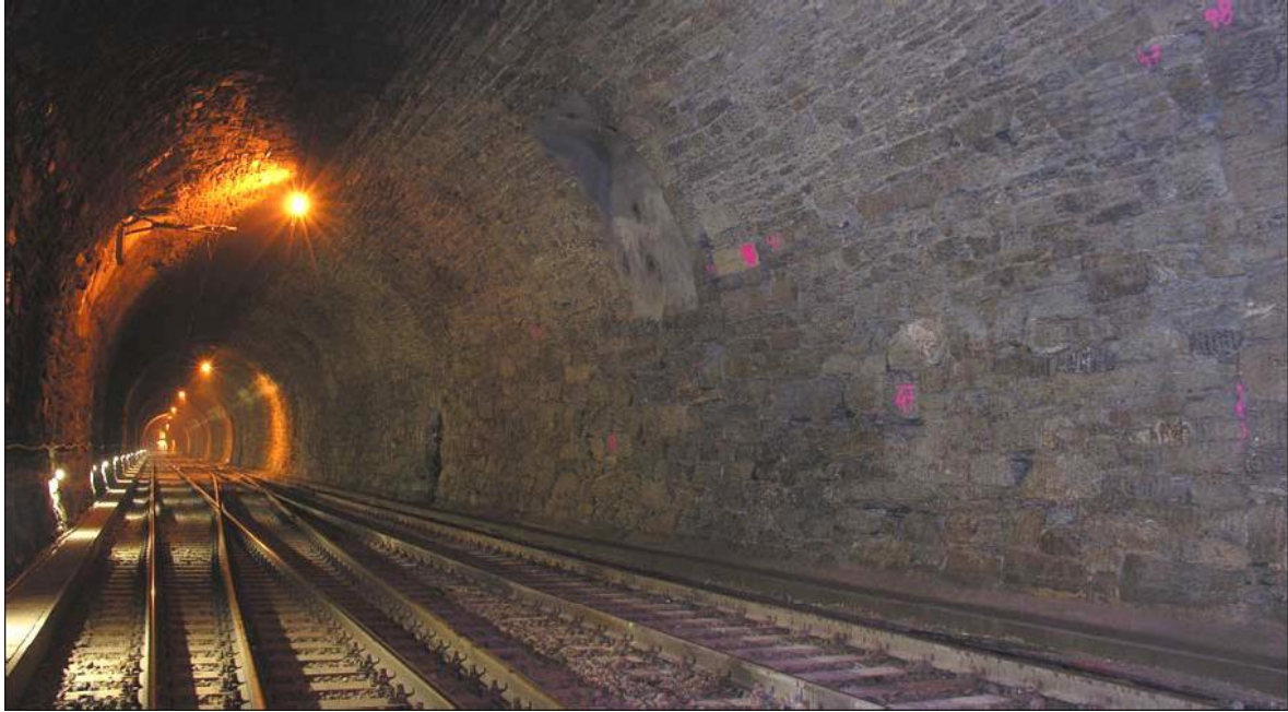
Abb. 24: Gewölbemauerung des Arlbergbahntunnels im Bestand (Gruppe Geotechnik Graz, 2008)
