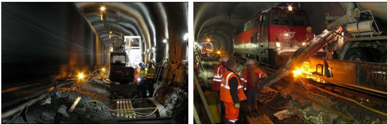
Abb. 26: Links: Bauarbeiten unter Beibehaltung eines eingleisigen Betriebs; rechts: Bauzug mit Betonmischer zum Einbringen von Sohlbeton (FCP, 2009)
