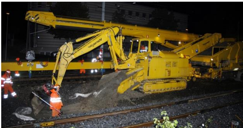
Abb. 17: Zwei-Wege-Bagger beim Beladen der Ladeschurre und anschließender MFS-Einheit (vanoli-ag.ch)
