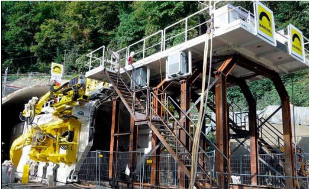
Abb. 21: Tunnelvortriebsportal beim Langenauer und Hollricher Tunnel (Simon, 2012)
