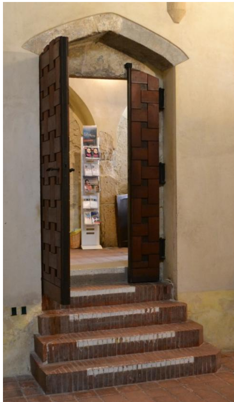
Abb. 39 li.: Eingang mit Stufen zu abgesenktem Bodenniveau Gemeindesynagoge Sopron
