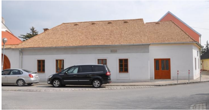
Abb. 76 li.: Westfassaden nach der Sanierung 2013
