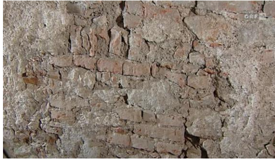
Abb. 92: Zugemauerte Fensteröffnung in der Ostwand 2012
