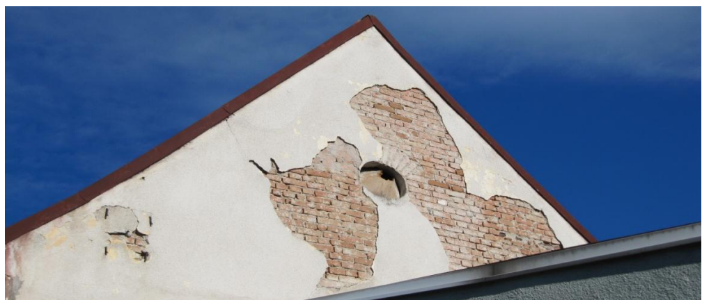
Abb. 80: Ostseitige Giebelwand der Aufstockung 2012; Kleinformatiges Ziegelmauerwerk ersichtlich
