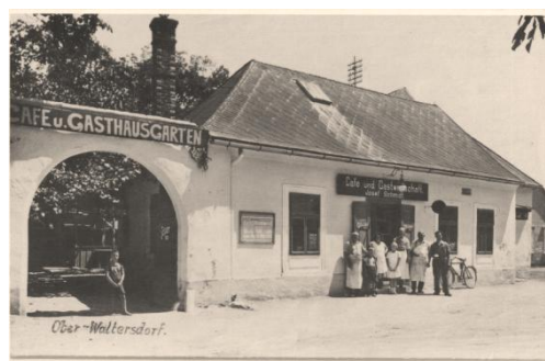
Abb. 68 re.: Historische Abbildung des Gasthauses in der Badener Straße 13
