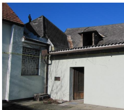
Abb. 93 re.: Dachstuhl des Gebäudeteil in der Südwestecke
