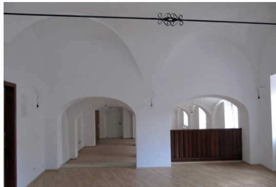
Abb. 78 li.: Gewölbe aus dem 16. Jhd. im Eckbereich
