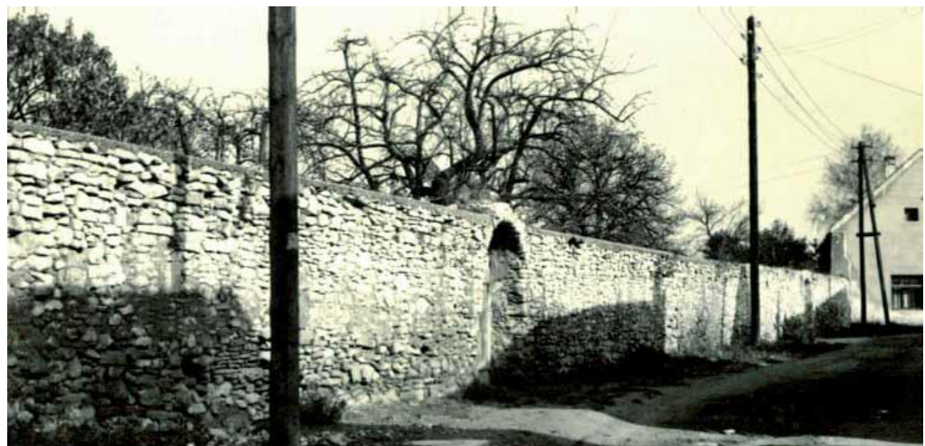
Abb. 140: Stadtmauer im Bereich der Annagasse in den 1950/60er Jahren
