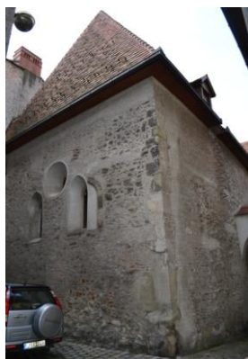
Abb. 12 li.: Nordostansicht Gemeindesynagoge Sopron
