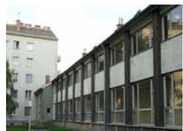
Abb. 60: Mittelbau nördliche Front
